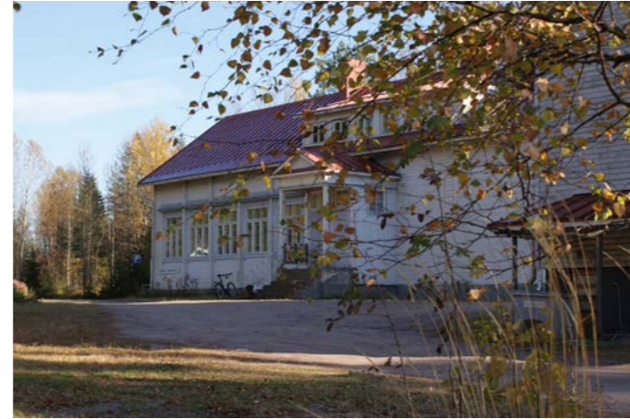
Kuva 2.30. Hiisiön vanha koulurakennus edustaa 1900-luvun alun klassismin kouluarkkitehtuuria.
