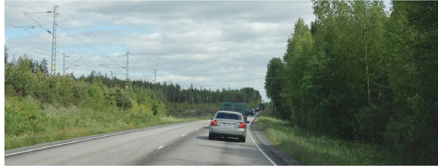
Kuva 2.3. Liikenne jonoutuu runsaan raskaan liikenteen ja tien huonon laatutason vuoksi.
