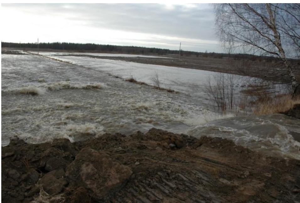
Bild 27. Lappfjärds ås nedre lopp öppnades en vall för att minska översvämningsskadorna våren 2013. (Kim Klemola)
