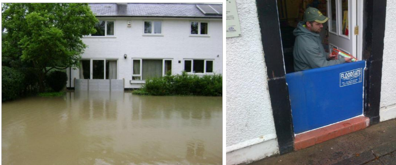
Bild 67. Exempel på skydd av dörrar och fönster vid en översvämning i Storbritannien vintern 2013–2014. (©Environment Agency).
