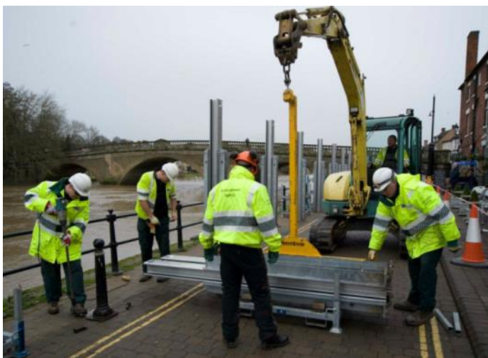
Bild 64. En tillfällig översvämningbarriär skyddar bosättningen längs floden Severn mot översvämning i Storbritannien våren 2014. (©Environment Agency)
