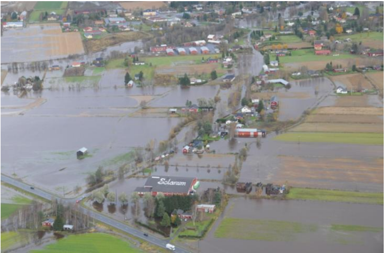
Bild 25. Översvämningen hösten 2012 spred sig till bebyggda områden i Lappfjärds tätort. (Unto Tapio)
