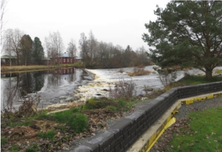
Bild 46. Exempel på översvämningvallar och -barriärer som byggdes vid Holmfors (t.v.) och Nybron (t.h.) i Lappfjärd under den första etappen. (Liisa Maria Rautio)
