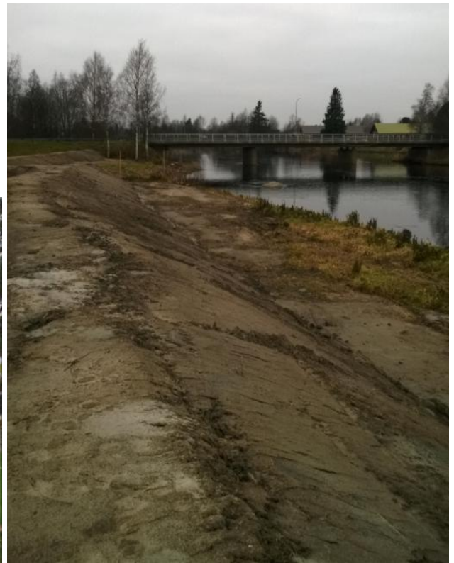
Bild 46. Exempel på översvämningvallar och -barriärer som byggdes vid Holmfors (t.v.) och Nybron (t.h.) i Lappfjärd under den första etappen. (Liisa Maria Rautio)
