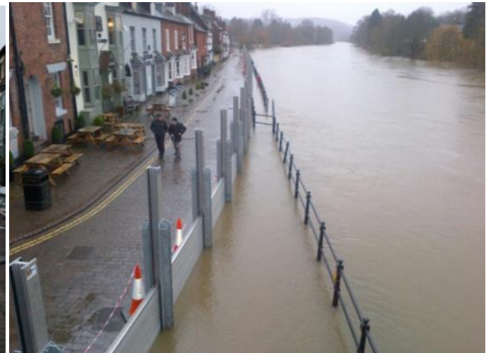
Bild 64. En tillfällig översvämningbarriär skyddar bosättningen längs floden Severn mot översvämning i Storbritannien våren 2014. (©Environment Agency)
