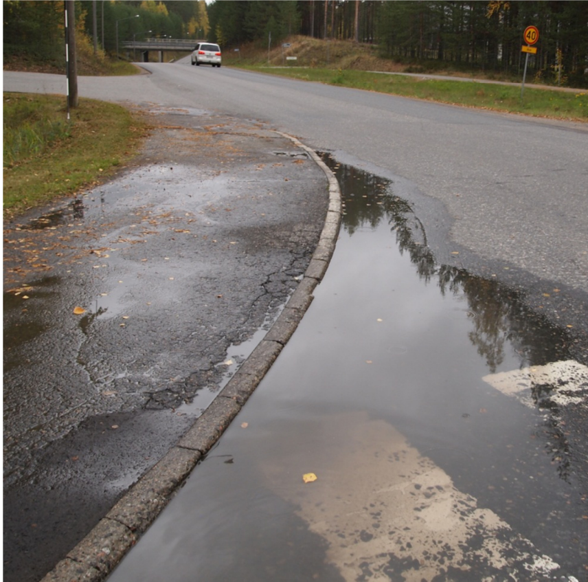
Kuva 3. Ylämyllyntiellä on ongelmia huonokuntoisen päällysteen, kuluneiden reunatukien ja kuivatuksen kanssa (kuva Ylämyllyntien ja Patteristontien liittymästä). (kuva: Finnmap Infra)
