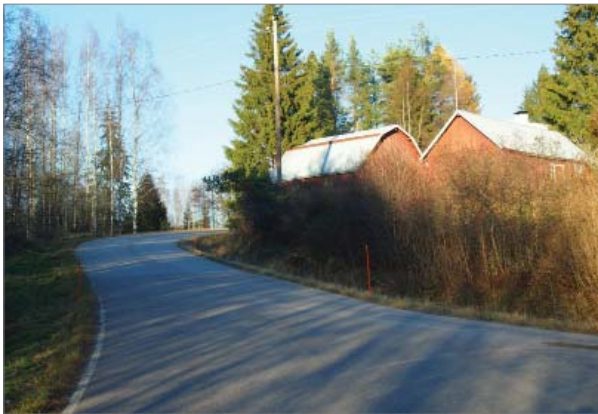
Pihapiirin kasvillisuutta on raivattava aika-ajoin, jotta näkemät tiellä säilyvät turvallisina. MP
