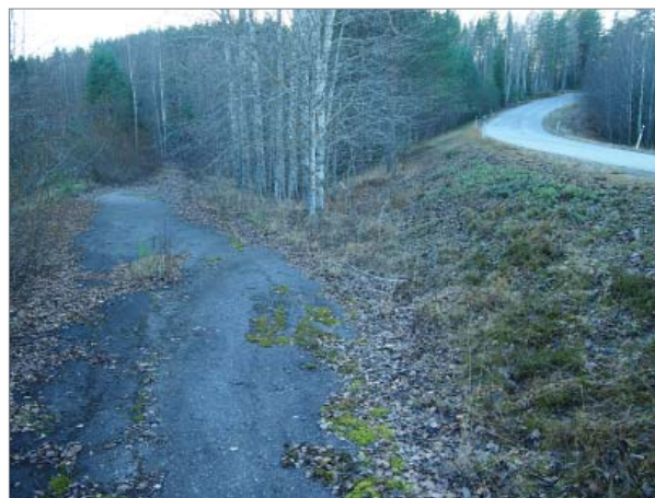
Tienoikaisu kilometripylvään 62/215 maastossa (Purnujärven Niuskanlahden laaksossa) on melko mittava, mutta sopeutuu hyvin tien vanhempaan linjaukseen ja tasoviivaan. MP
