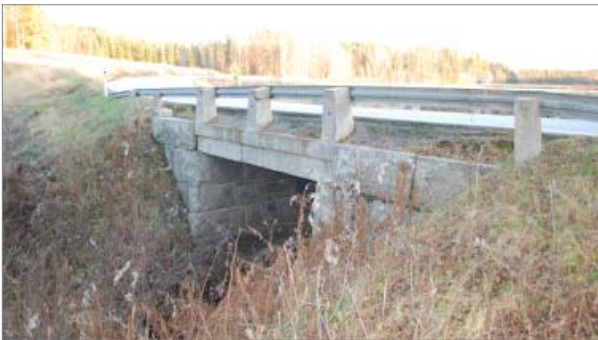
Niittusuonojan ylittävä kivisilta, Honkasilta. Silta on rakennettu vuonna 1930. LS
