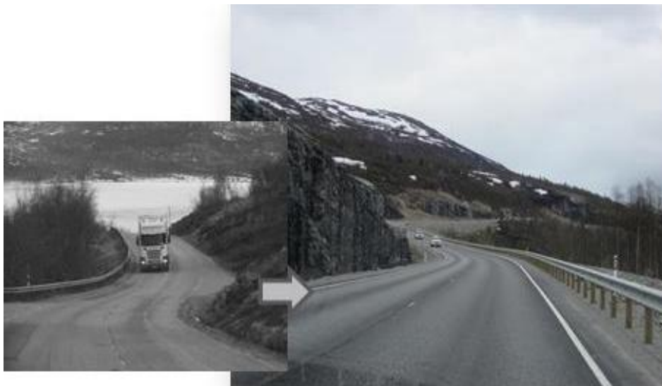
Kuva 14: Havainnekuva tien parantamisen periaatteesta Kilpisjärven eteläpuolella. Pikkukuvassa nykyiset mutkat ja isossa kuvassa vastaavan tien parantamiskohteen esimerkkiteotus Norjan puolelta E8-valtatieltä Kilpisjärven ja Skibotnin väliltä.
