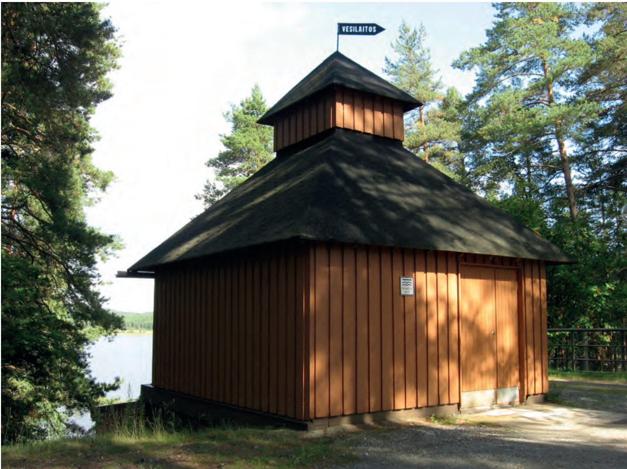
Kötsinmäen vedenottamo Porokylän I-luokan pohjavesialueella Nurmeksessa, kuva Airi Määttä
