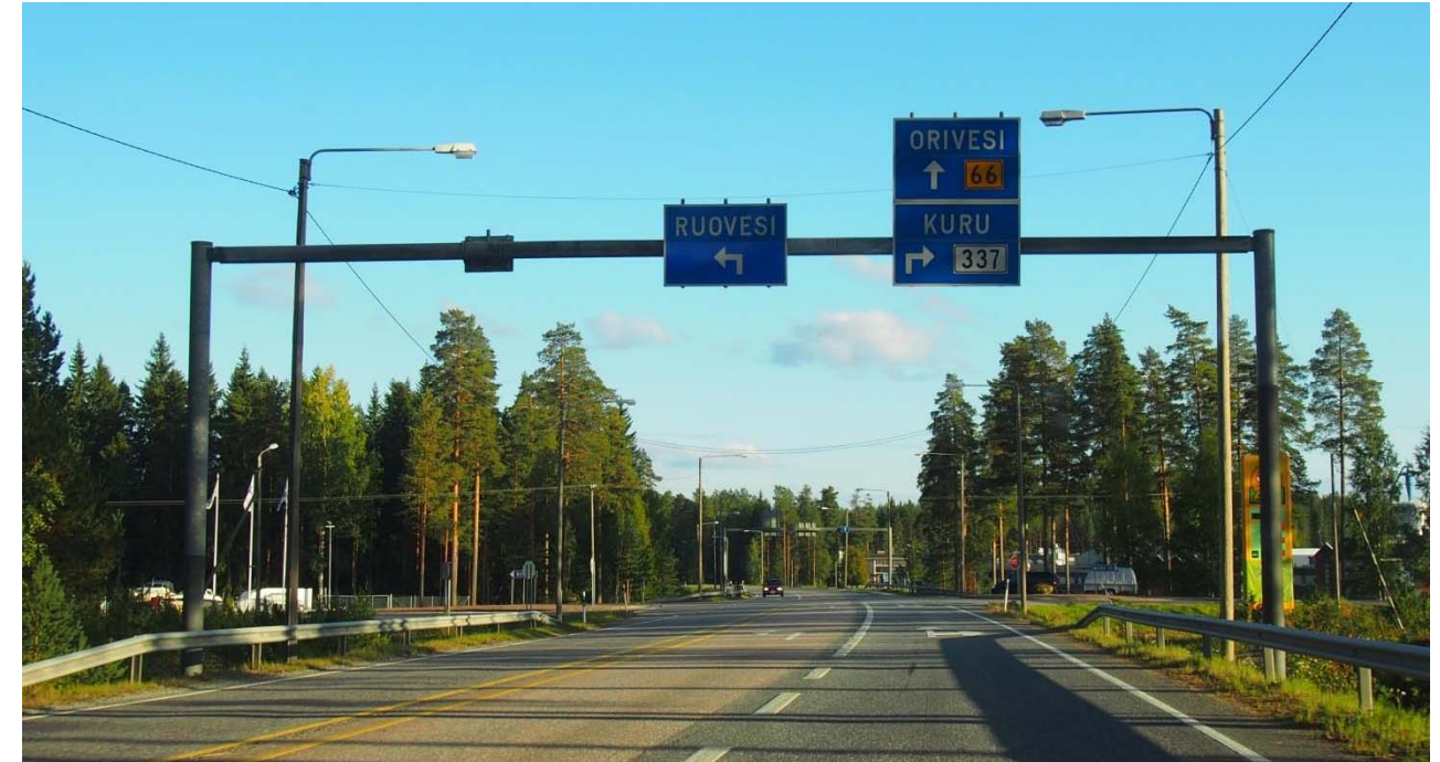
Kuva 10. Toinen matalista kokoportaaleista Kirkkokankaan liittymässä kantatiellä 66 (kuva: Kimmo Heikkilä).
