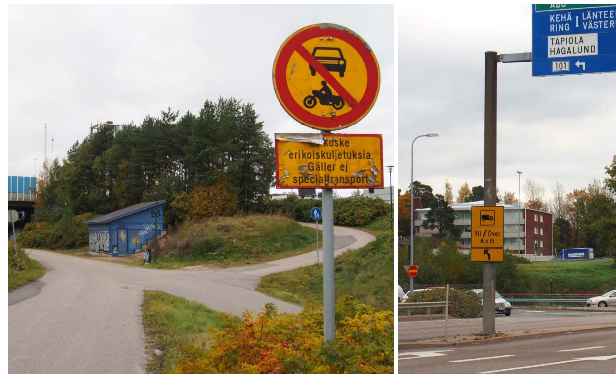
Kuva 3. Joidenkin kiinteiden ulottumaesteiden kohdille on tehty paikallisia kiertoja erikoiskuljetuksille esimerkiksi viereisen silta-aukon kautta jkpp-väylää pitkin, kuten Espoon Leppävaarassa. Kuvat: Kimmo Heikkilä.
