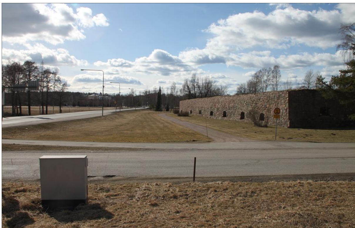
Bild 0-1. Bastion Ungern som byggts som yttre skydd för Lovisa fästning (Bild: FCG Suunnittelu ja tekniikka Oy).
