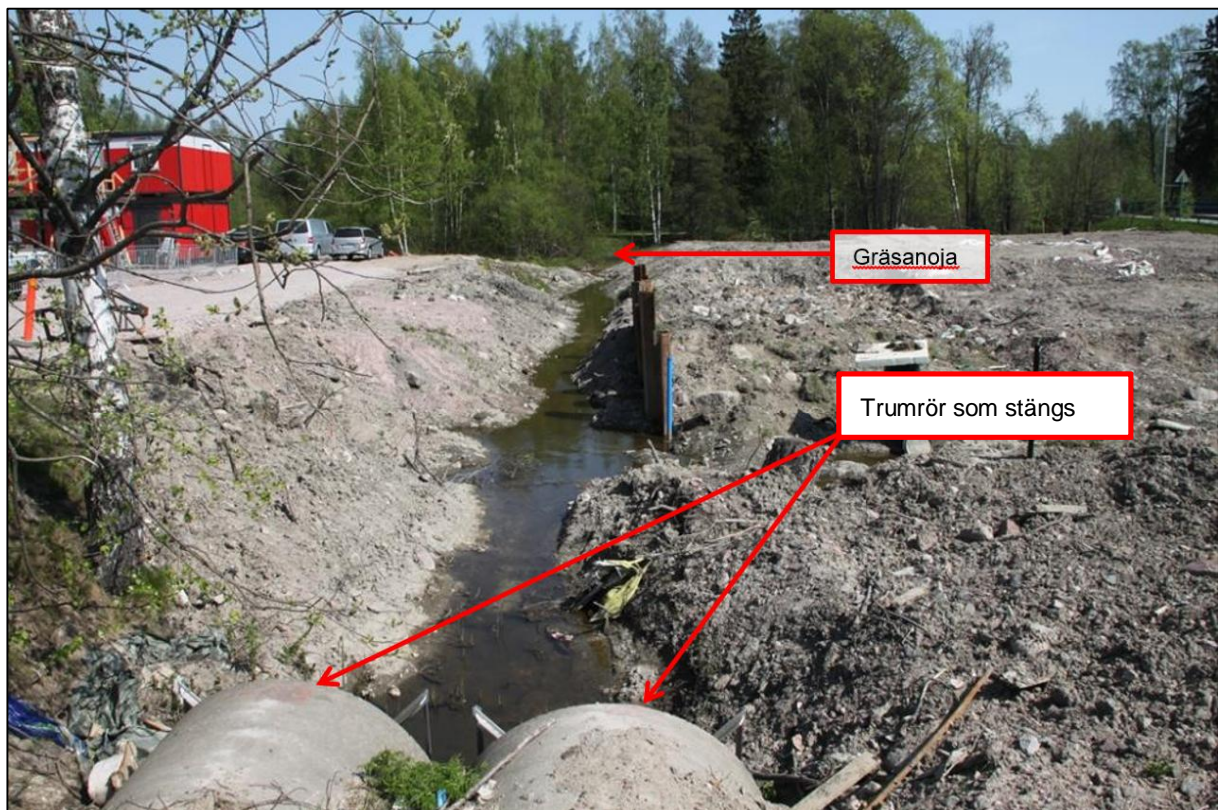
Bild 10.4.3-2. Stängning av vägtrumman vid Mattbäcksstigen och den riktgivande placeringen av tillfällig konstruktion för uppdamning av översvanningsvattnen (på kartan vid en översvämning med ett återkomstintervall på 1/100 a).
