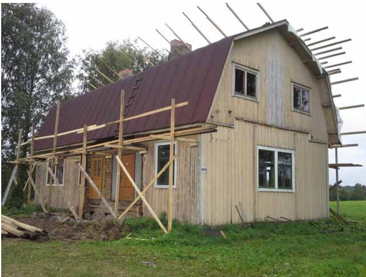
KUVA 15. Perinteisen maatilan päärakennuksen kunnostus on aloitettu. Koskenniemi, Kiekkä.
