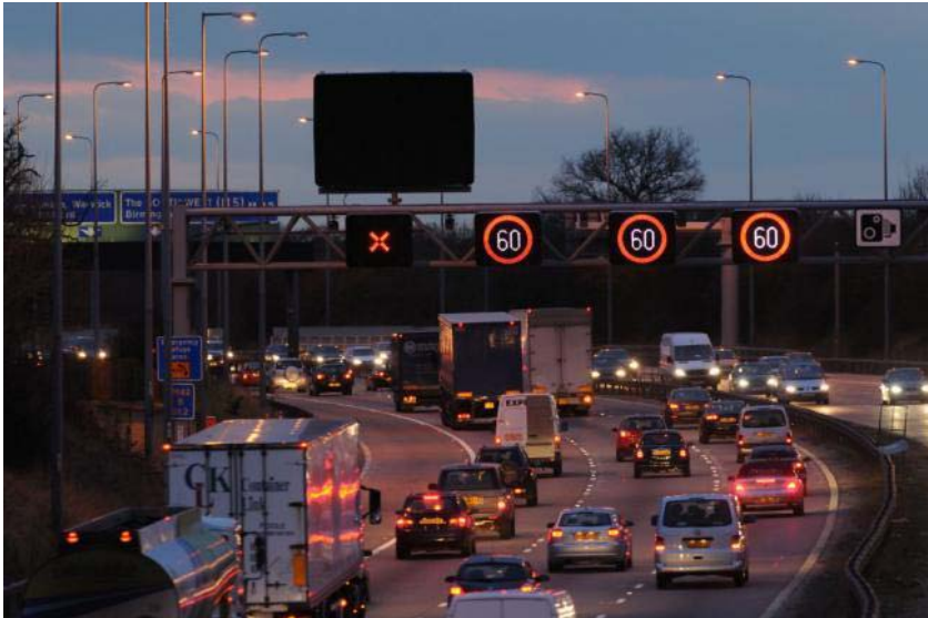
Kuva 19. Smart motorway Englannissa varustettuna vaihtuvien nopeusrajoituksin, tiedotusopastein, piennarkaistan dynaamisella käytöllä sekä automaattivalvonnalla.
