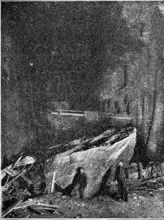
200 tonnin painoinen suolamöhkäle, joka on pudonnut taksain kaivokseen.
