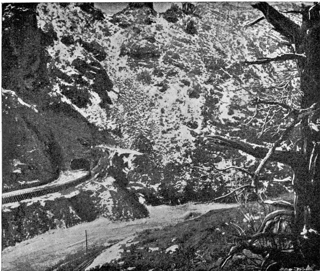
Tunnelin toinen pää, mistä kanava alkaa.
