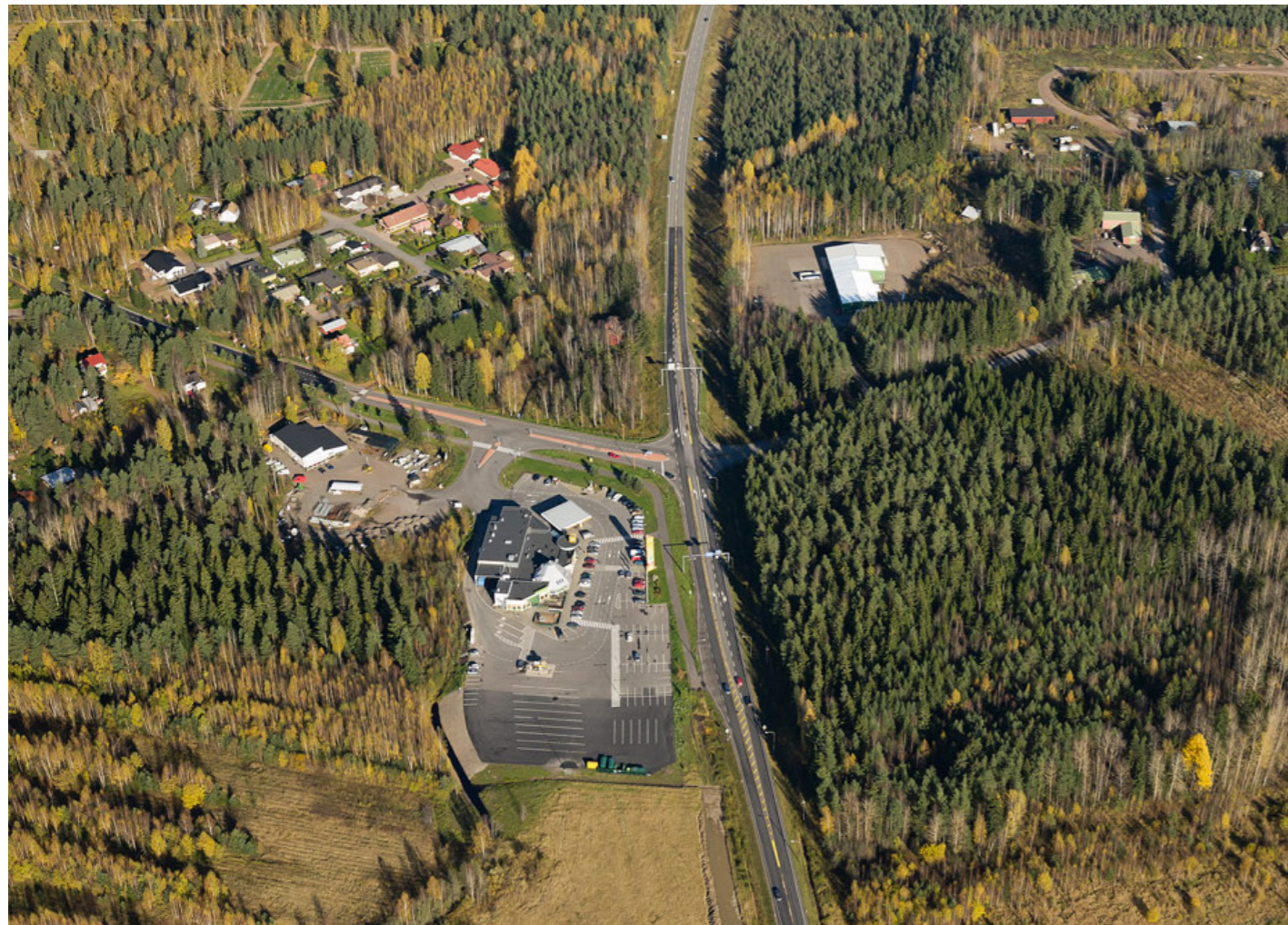
Kuva 3.8. Valkealan liittymän liikenneturvallisuus on erittäin huono ja myös sivusuuntien liikenteen sujuvuudessa on päivittäisiä ongelmia.
