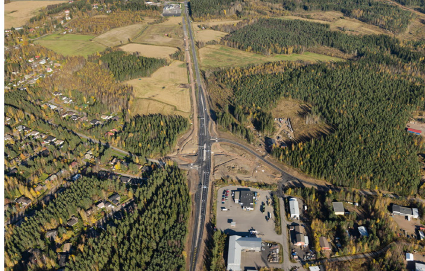
Kuva 2.3. Niinistön liittymä on parannettu porrastetuksi tasoliittymäksi.
