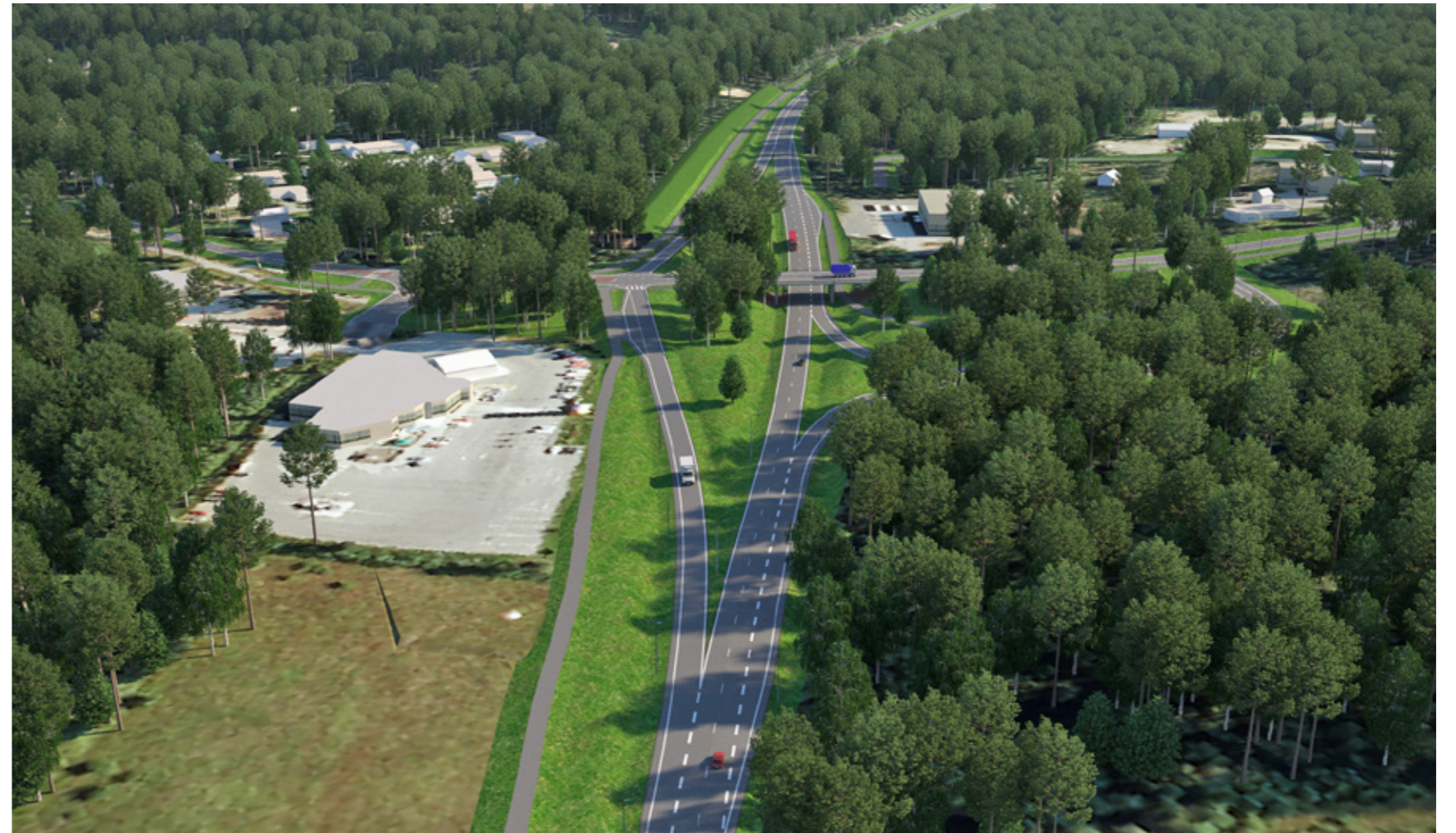
Kuva 4.8. Valkealan liittymä parannetaan eritasoliittymäksi. Havainnekuva Kouvolan suunnasta Mikkeliin.
