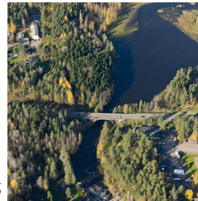
Kuva 3.6. Käyräjoen nykyinen silta on painorajoitettu ja vaatii peruskorjausta.
