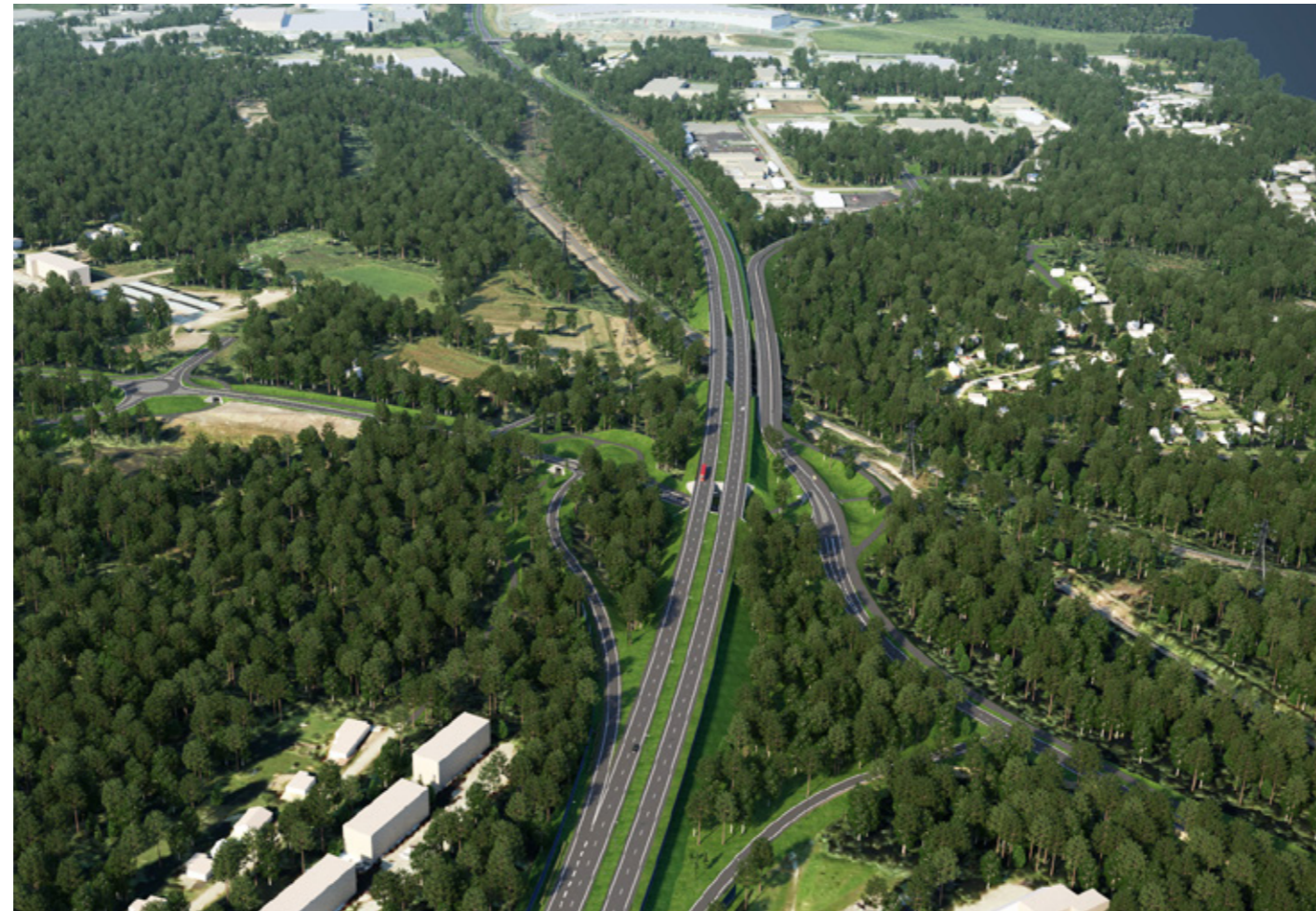
Kuva 5.7. Valtatieen 6 parantaminen rinnakkaiskatujärjestelyineen tukee Kouvolan keskeisen ydinalueen kehittämistä. Kuva Tanntarista Puhjon–Tervaskankaan alueen suuntaan.
