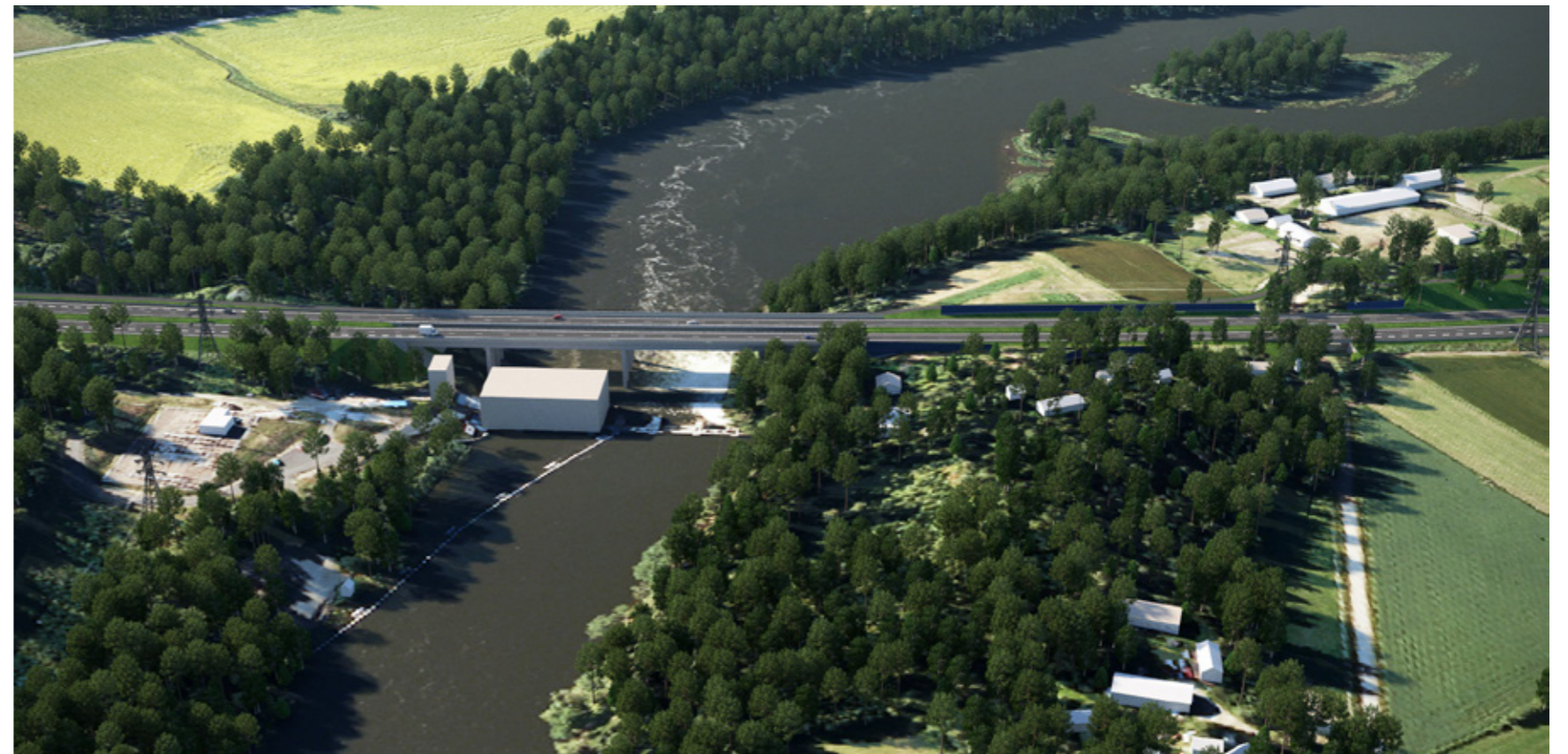
Kuva 5.17. Kymijoen sillassa turvataan ympäristön säilyminen rantavyöhykkeellä. Kuva pohjoisesta etelään.
