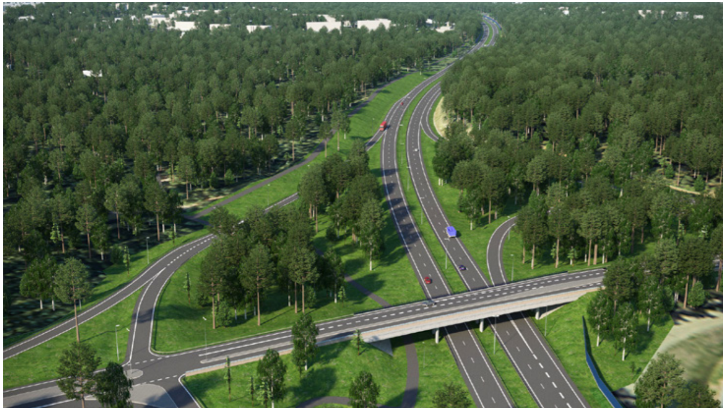
Kuva 5.30. Tien parantaminen 4-kaistaiseksi moottoritieksi parantaa oleellisesti liikenteen sujuvuutta ja turvallisuutta. Kuva valtatieltä 6 Käyrälammen eritasoliittymästä Kouvolan keskustan suuntaan.
