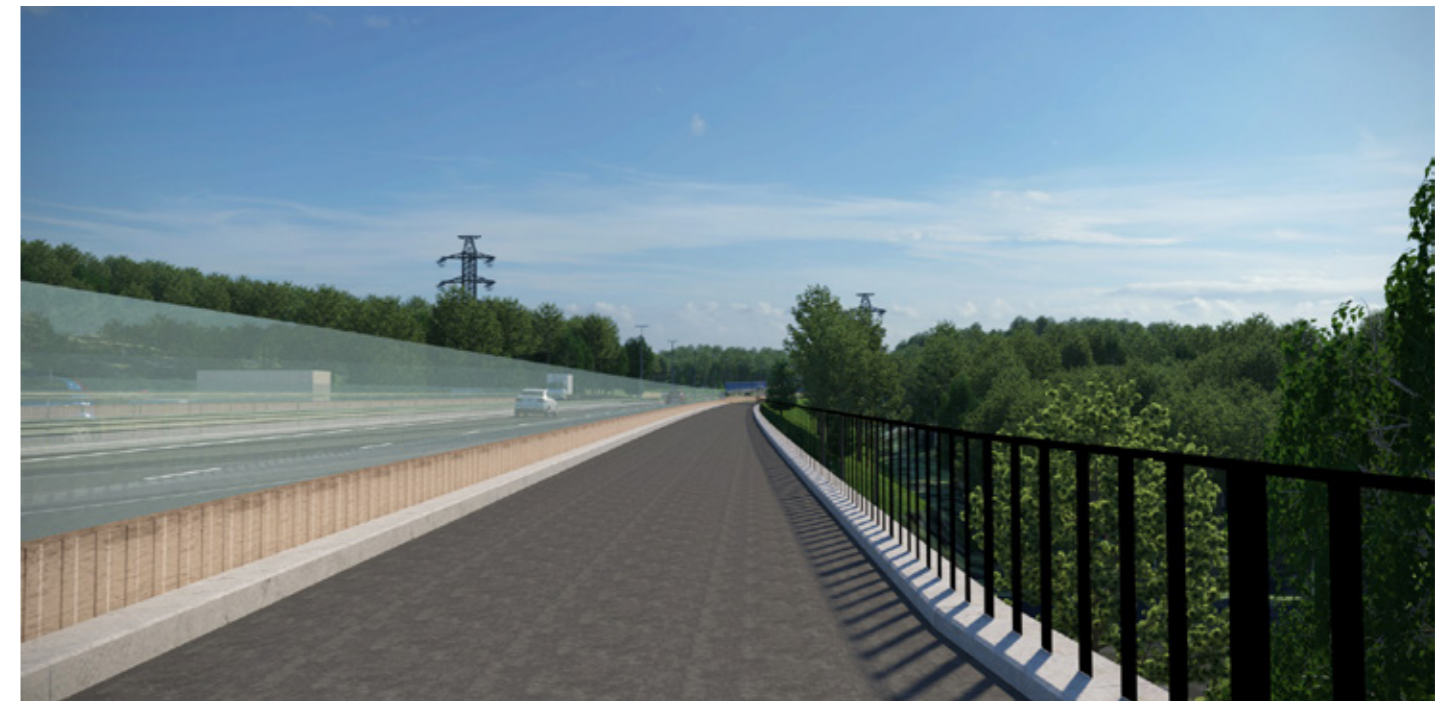
Kuva 4.19. Kymijoen uudessa sillassa käytetään läpinäkyviä melusteitä näkymien avaamiseksi.
