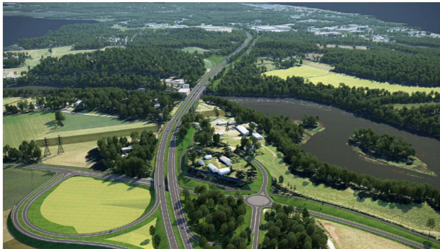
Kuva 5.36. Kiireellisimpiä toteuttamiskohteita ovat Keltin sillan korjaukseen liittyvä valtatieparantaminen ja Keltin länsisuunnan rampit. Kuva Keltistä Kouvolan suuntaan.
