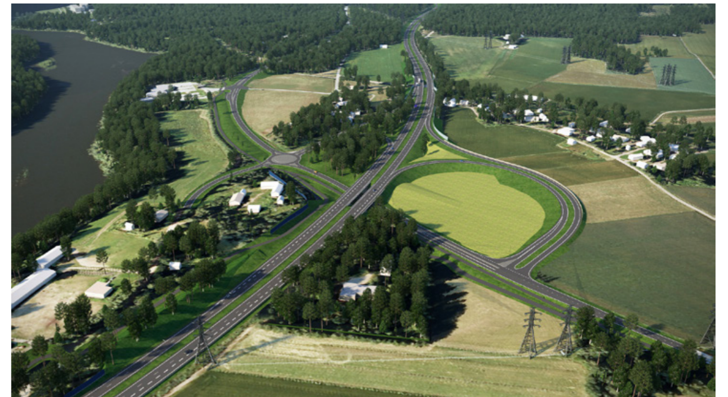
Kuva 5.37. Keltin eritasoliittymän uusilla rampeilla saadaan poistettua yksi keskeinen palvelutasopuute valtatieverkolta. Ne voidaan toteuttaa erillisenä hankkeena. Kuva Keltistä Helsingin suuntaan.
