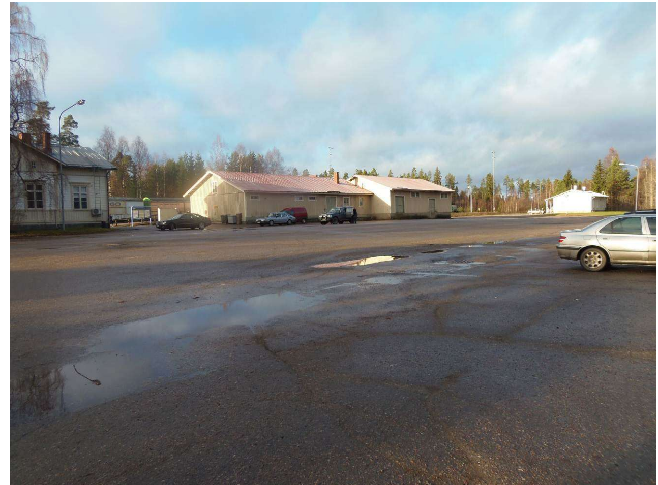
Kuva 14. Asema-aukio on nykytilanteessa laaja, jäsentymätön kenttä.
