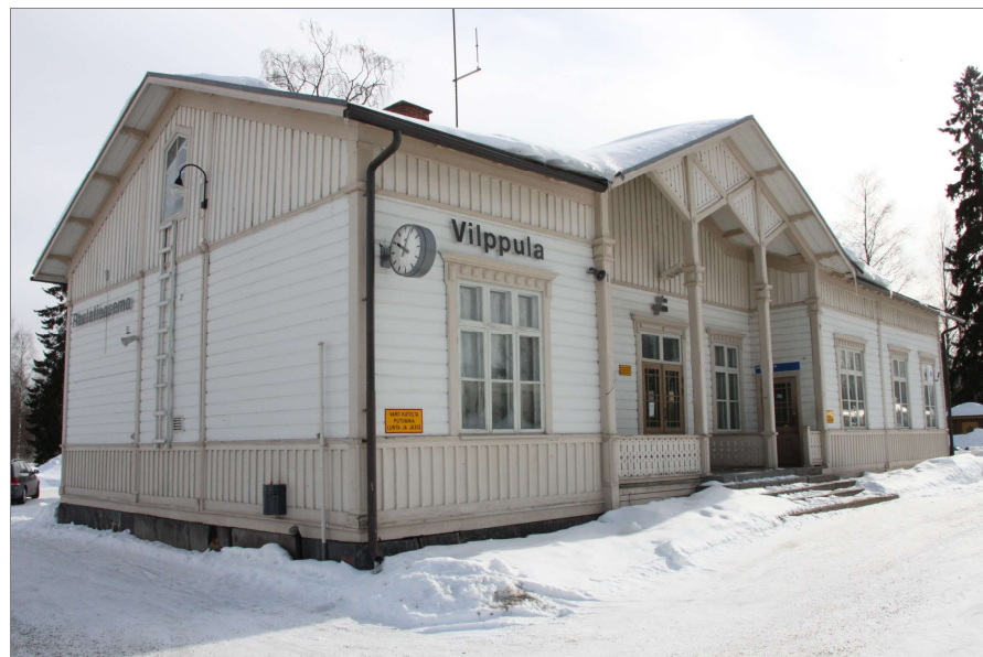
Kuva 4. Vilppulan rautatieasema Keskuskadun pohjoispäässä on liikennehistoriallisesti merkittävä kohde, ja se on osoitettu valtakunnallisesti merkittäväksi kulttuuriympäristöksi.
