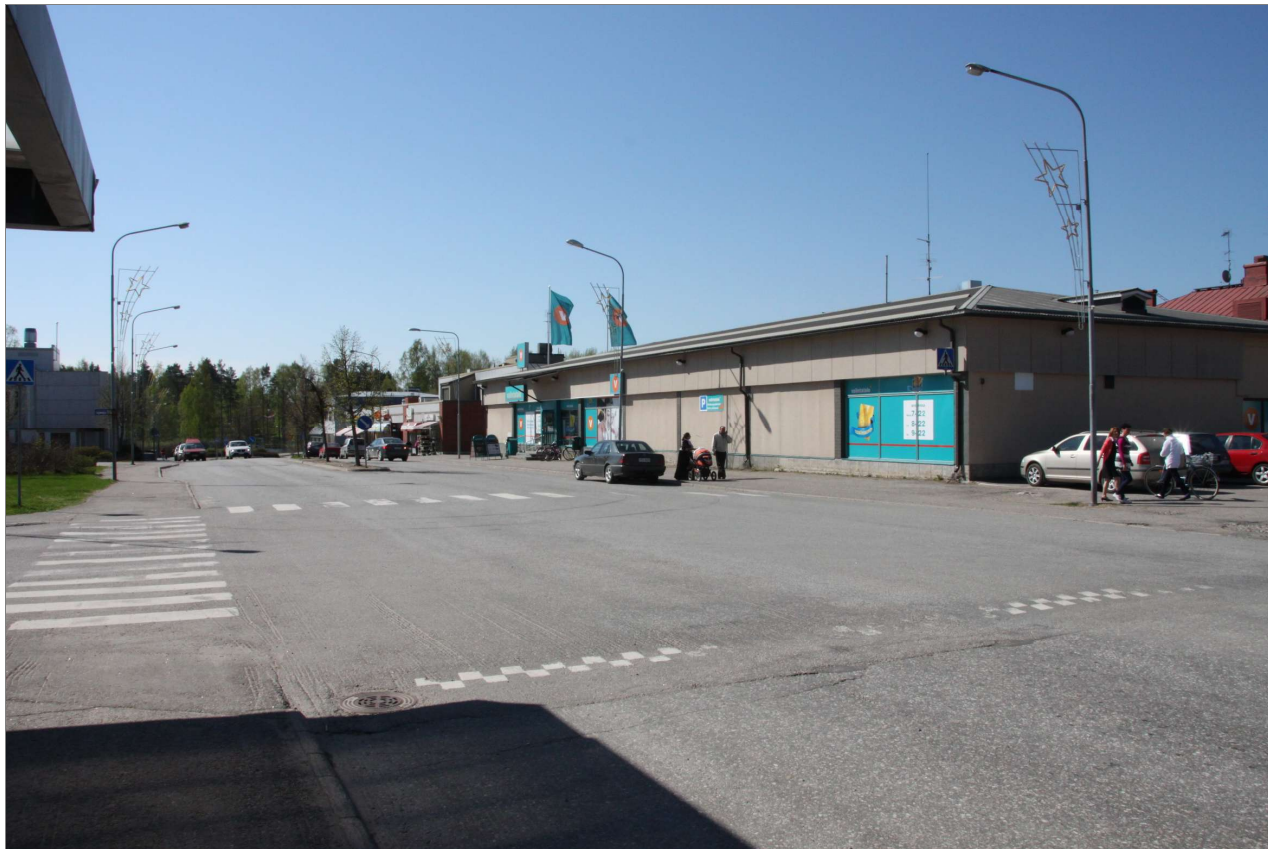
Kuva 7. Keskuskatu Vankankadun korotetun liittymän kohdalla. Suojatiet ovat pitkiä ja liikennenympäristö jäsenymätön.
