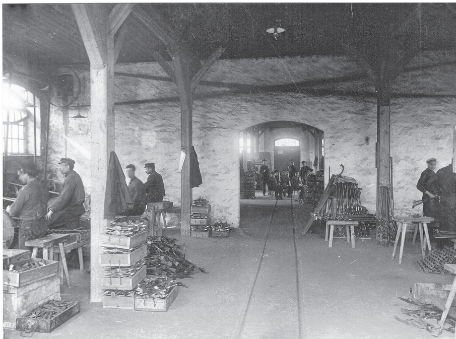
Bild 5. Interiör från sliperiet kring 1930. På bilden slipar smederna bl.a. yxblad som transporterats med en vagn från smedjan längs med ett spår som löpte genom produktionsavdelningarna. Den slipade yxbladen transporterades vidare för att få handtag som tillverkades i träavdelningen. Källa: Bi 981 Snickeriexteriörer, Pojo Fotoklubb mapp Billnäs bilder, Pojo lokalhistoriska arkiv.
