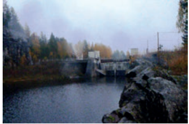
Kuva 16: Lieksankosken säännöstelypato alavirrasta päin kuvattuna.
