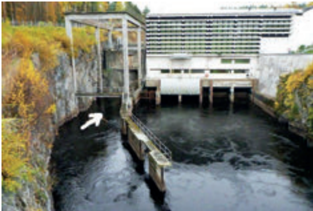
Kuva 23: Rysän sijainti voisi olla nuolen osoittamassa kohdassa, Samaan kohtaan sijoittuisi myös emokalapyyntilaitte.
