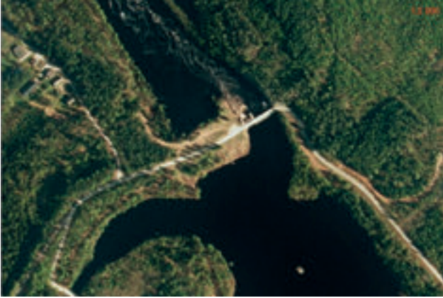
Kuva 15: Lieksankosken säännöstelypato ja Lieksankosken voimalaitokselle johtavan tunnelin yläpää (kuvan vasen alareuna).
