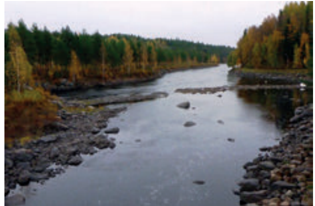
Kuva 20: Kuva alavirtaan päin Lieksanjoen vanhan uoman riippusillalta. Kuvan keskellä näkyy houkutusvirta-aukko, jota tulisi muokata. Tulvavirtaamat ovat myös kuluttaneet pohjapatoa/pengertä.
