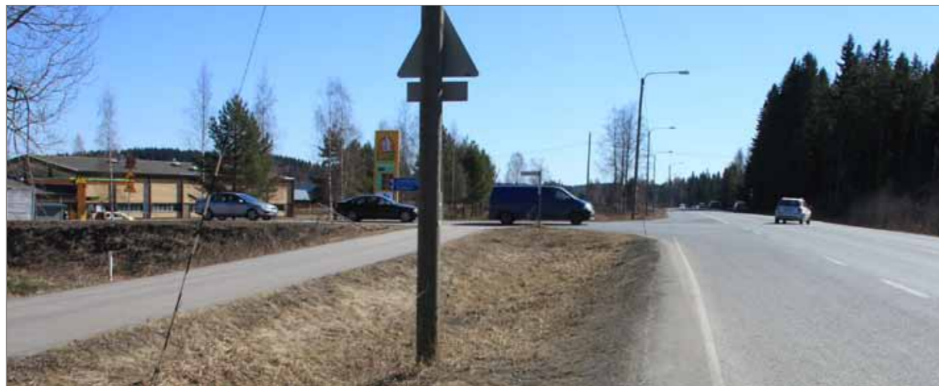
Kuva 3.19 Vehkoontien liittymässä Asikkalassa on tapahtunut useita omaisuusvahinko- ja henkilövahinko-onnettomuuksia.
