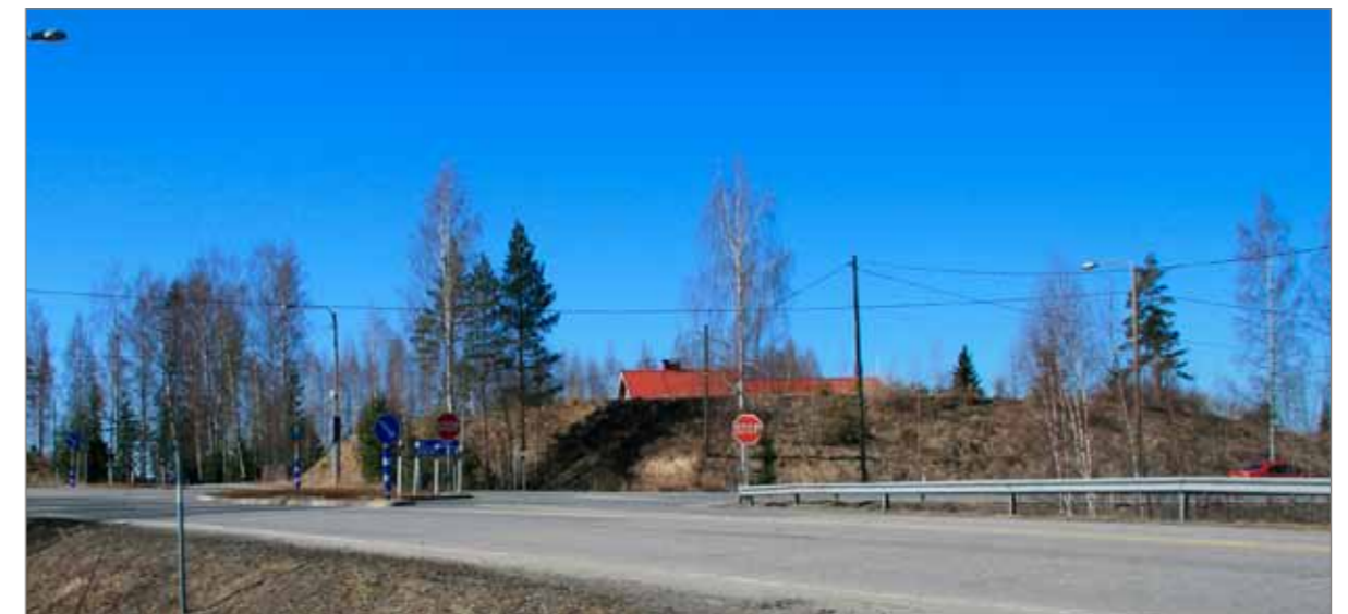
Kuva 3.20 Yksityinen meluvalli omakotitalon suojana Hollolassa, Vesivehmaantien (mt 3131) ja Paimelantien (mt 14119) liittymässä.
