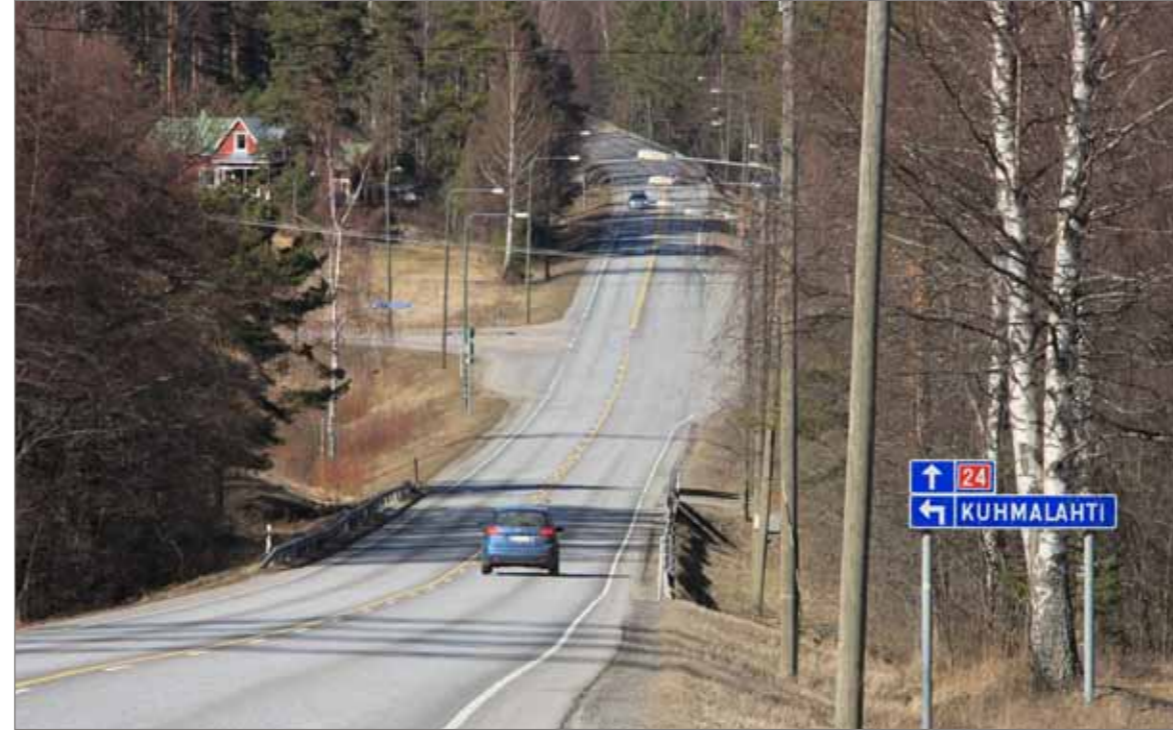
Kuva 5.12 Pohjoisella tarkastelujaksolla 3 liikennemäärät ovat ennustetilanteessakin sen verran alhaisia, että nykyiset liittymäratkaisut täyttävät palvelutasotavoitteet. Kuvassa Kuhmalahdelle johtavan Kaukelantien (mt 3254) liittymän väistötilajärjestelyt Padasjoen Arrakoskella.
