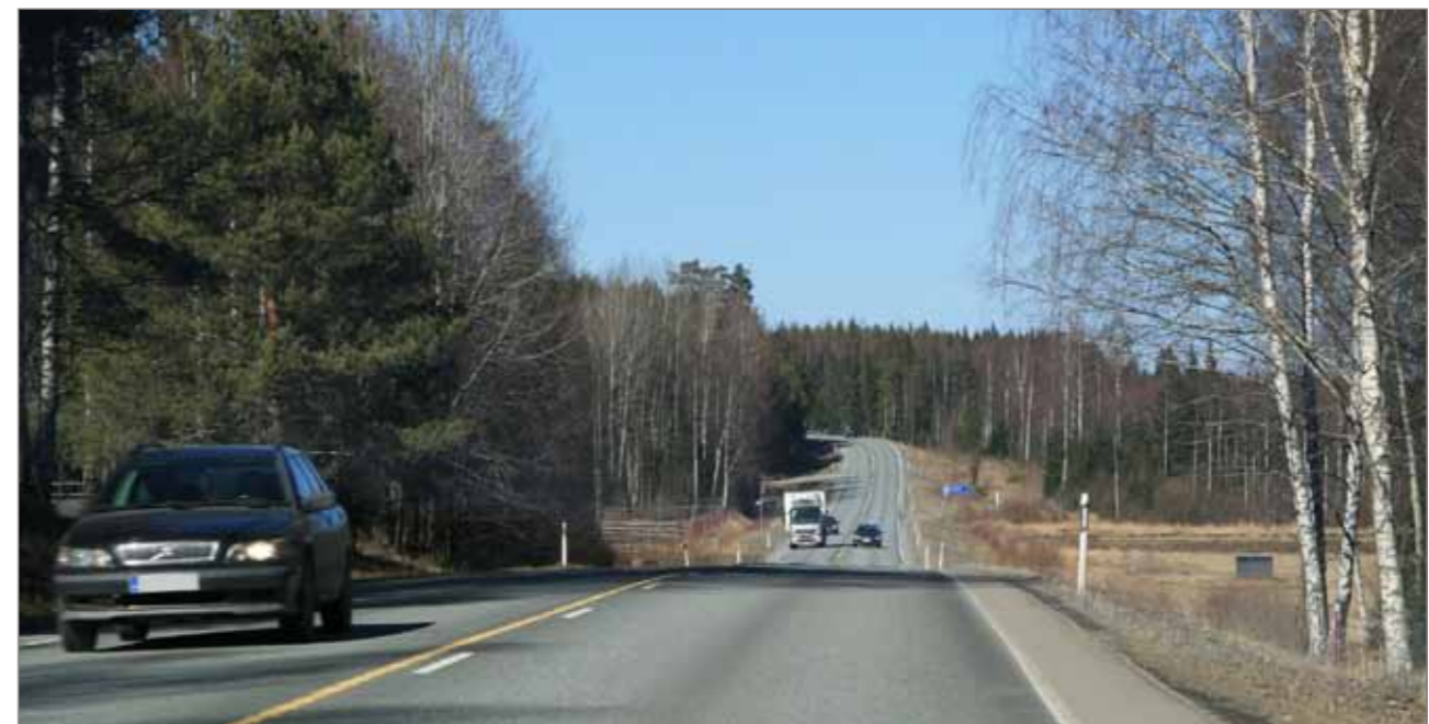
Kuva 4.5 Vähäiset ohitusmahdollisuudet ja kohtuullisen suuri raskaan liikenteen osuus aiheuttavat riskiohituksia sulkuviivan kohdalla. Kuva Asikkalan ja Padasjoen kuntarajalta, Asikkalan puolelta.
