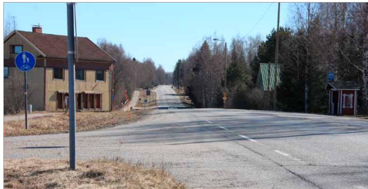
Kuva 4.4 Iso-Äiniön kylän kohdalla Asikkalassa tiessä oleva notkelma aiheuttaa osittaisen näkemäkatveen. Kuva on otettu läheisestä Myllykseläntien (mt 14141) liittymästä.
