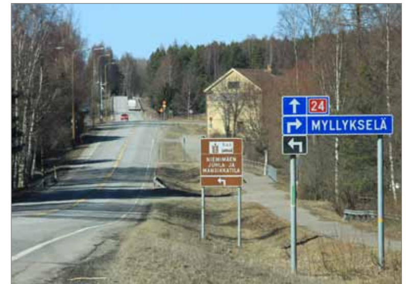
Kuva 5.10 Myllykseläntien (mt 14141) liittymä Iso-Äniön kylämaisella jaksolla, jossa on myös pystygeometrian vuoksi rajoitunut liittymänsäkö (toimenpide 38).
