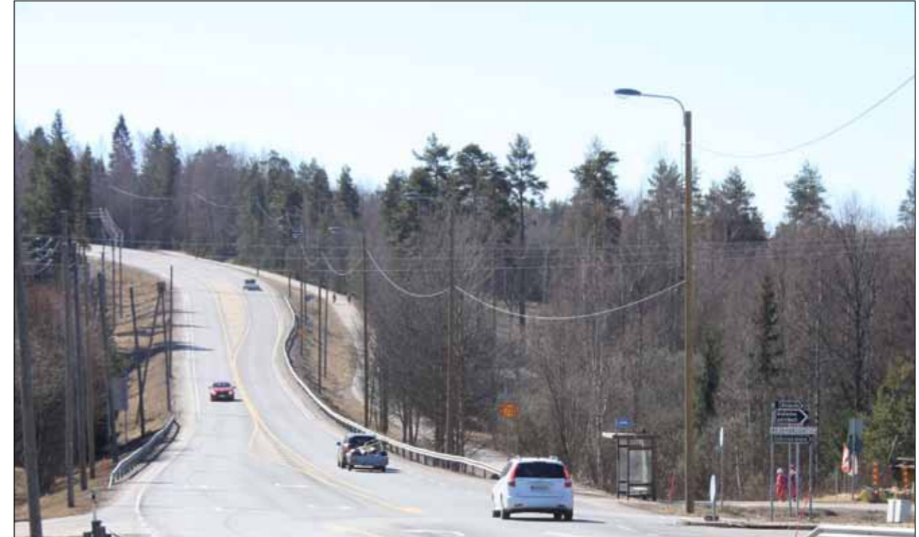
Kuva 3.16 Kevyen liikenteen väylän tasaus Tuhkamäen kohdalla Hollolassa on huonompi, kuin viereisen valtatie.
