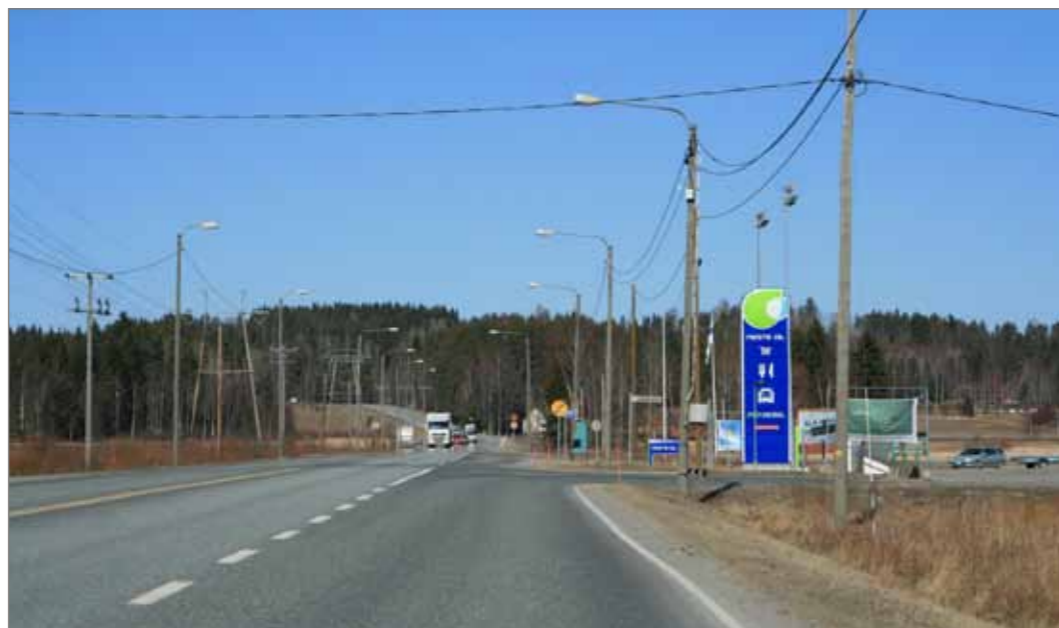
Kuva 6.1 Joenkulmantien, Vehnämäentien ja huoltamon liittymät kääntymiskaistoiheen muodostavat epämääräisen kokonaisuuden, jota on syytä jäsentää.
