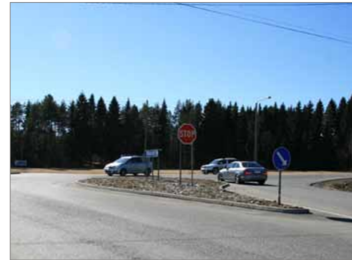
Kuva 5.14 Taulun liittymässä (kt 53) Padasjoella on ns. pisarsaarekkeet.
