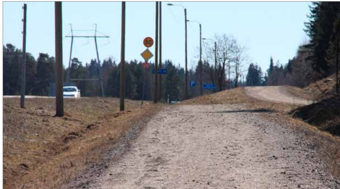
Kuva 4.2 Sorapintainen kevyen liikenteen väylä Hollolan Paimelassa. Osa pyöräilijöistä käyttää mieluummin valtatie asfalttoitua piennarta.
