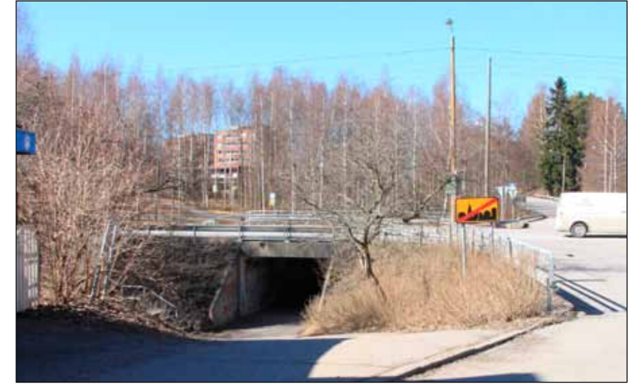
Kuva 3.14 Merrasjärven alikulkukäytävä Lahdessa, Väyläkadun ja Merrasojantien katuliitymässä.
