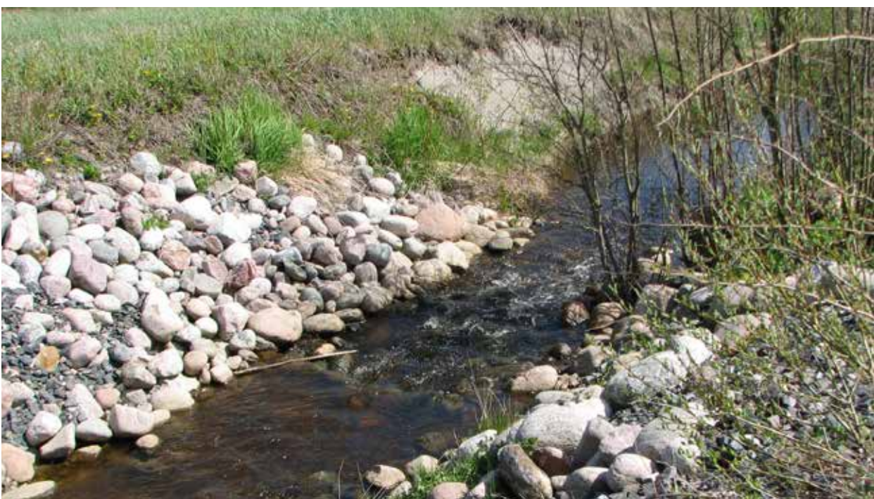
Peltopuroon on tehty luonnonmukainen kunnostus. Kuva (Perniön Juottimenojasta): Anni Karhunen
