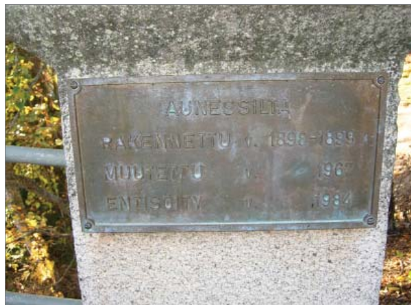
Sillan rakentamis- ja kunnostusvaiheet on dokumentoitu pilariin kiinnitettyyn laattaan. Kuva Laura Soosalu
