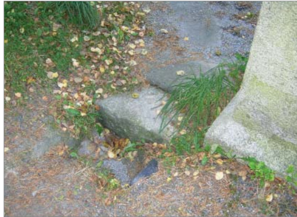
Askelkivet asennetaan maaston mukaan niin, että niitä pitkin on mahdollista laskeutua rantaan, mutta kivet eivät korostu, vaan jäävät osin piiloon kasvillisuuden lomaan. Kuva ukkopöytävierestä. Kuva Laura Soosalu
