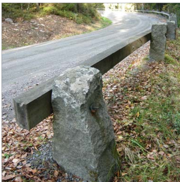
Ympäristöön hyvin sopiva puinen tiekaide. Nopeusrajoituksen laskua 40 km/h tulee harkita mutkan kohdalla. Matalasta pengerkaiteesta voidaan varoittaa liikennemerkillä. Kuva Laura Soosalu
