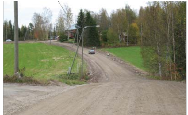
Lännestä kohti Seurataloa tien varret näkyvät siisteinä. Oikealla vastarinteessä on uusittu sivuohjarrumpu. Rummun vanhat sementtiputket ovat vielä tienpenkalla. Muovi katoaa näkyvistä heti, kun maan nurmettuu tulevana kesänä. Kuva Tapio Mård
