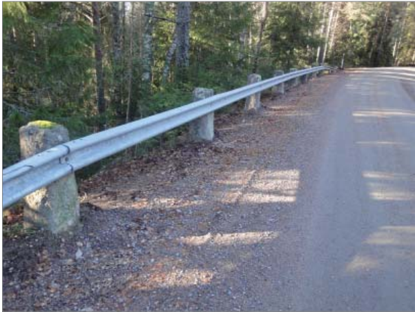
Työ on tehty huolellisesti. Tiepalle, "jätjänpolku", on poistettu kaitteen kohdalta. Kuva Martti Piltz
