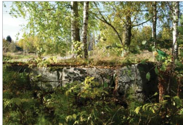
Luonnonkivistä rakennettu komea ja hyväkuntoinen tukimuuri. Kuva Laura Soosalu
