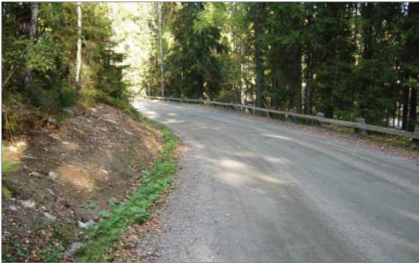
Tien reunan puinen kaide. Tien vasempaan luiskaan on kesällä 2013 kaivettu kaapeli. Kuva Laura Soosalu
