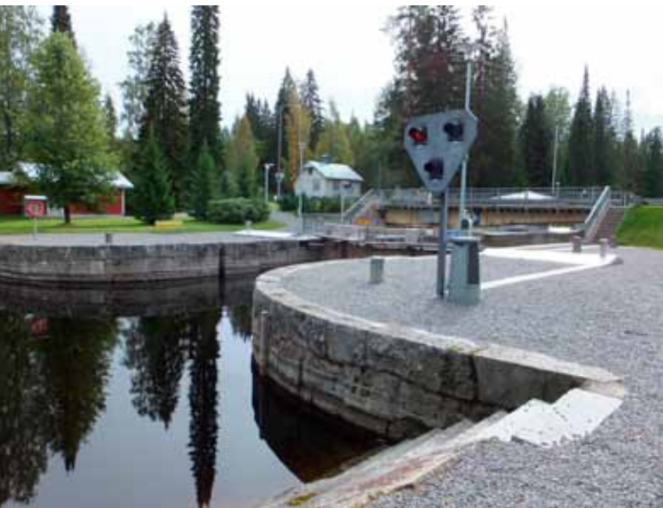
Kuvat: (ylhällä) Alueella on arvokasta rakennuskantaa. (keskellä) Maisema-alueen eteläosan maisema on pienipiirteisempää. (alhaalla) Muroleen kanava. (viereisellä sivulla) Vesistöt ovat tärkeässä osassa.
