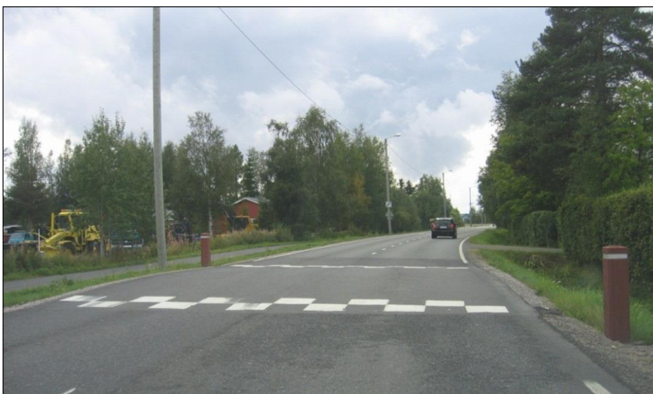
Kuva 44. Esimerkki uudentyyppisestä loivapiirteisestä töyssystä. Kuvassa Kempeleessä oleva tie, jolla on 40 km/h nopeusrajoitus.
