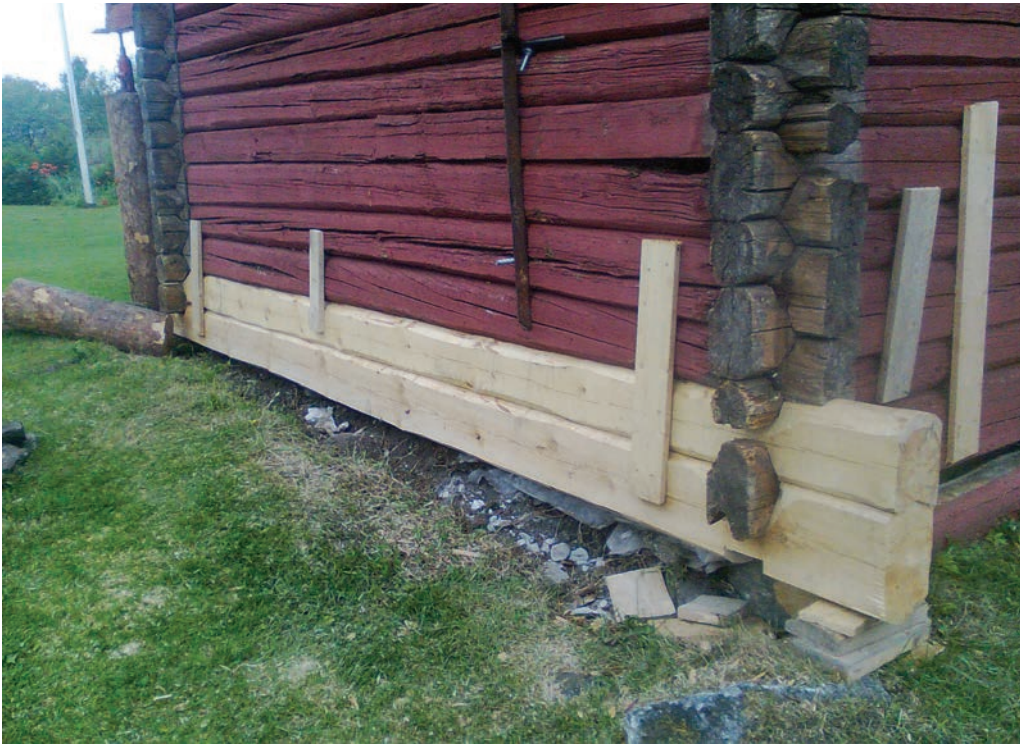
KUVA 18: Hirsirakennuksen kengitystä. Kutemajärvi.
