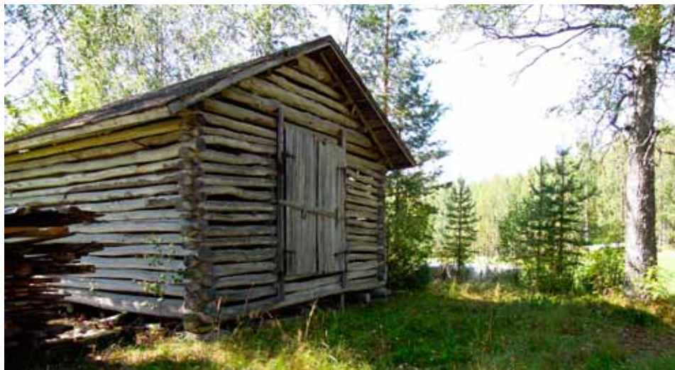
Kuva 73. Lato metsäsaarekkeella (Kohde 51J.)
