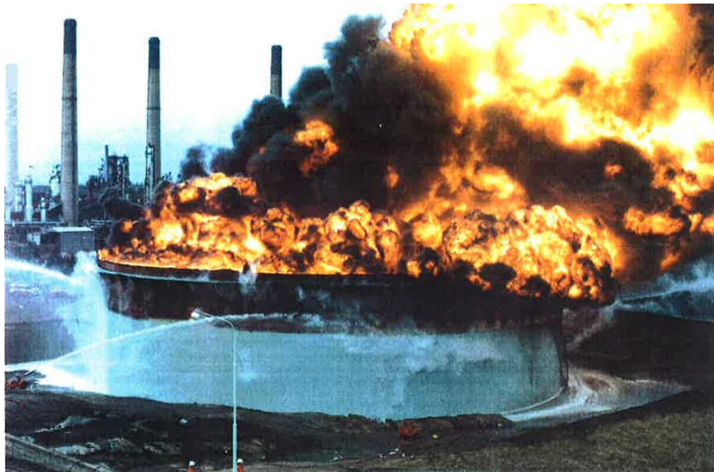
Kuva 3. R2 säiliön tulipalo Kilpilahdessa 23.–24.3.1989 (Neste Oil Oyj).
