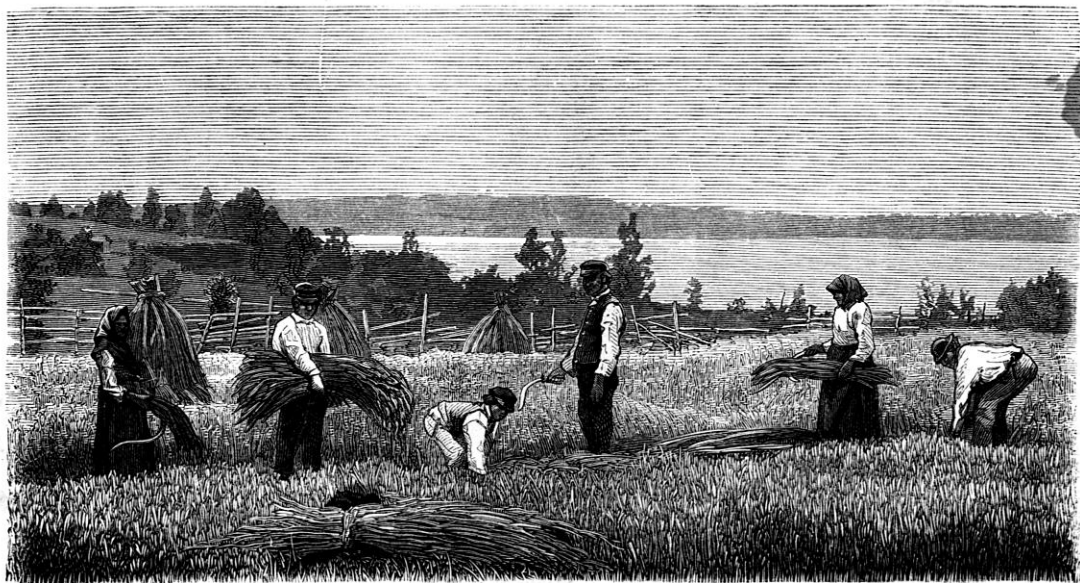
Bild 16. Rågskörd vid Ruovesi.
