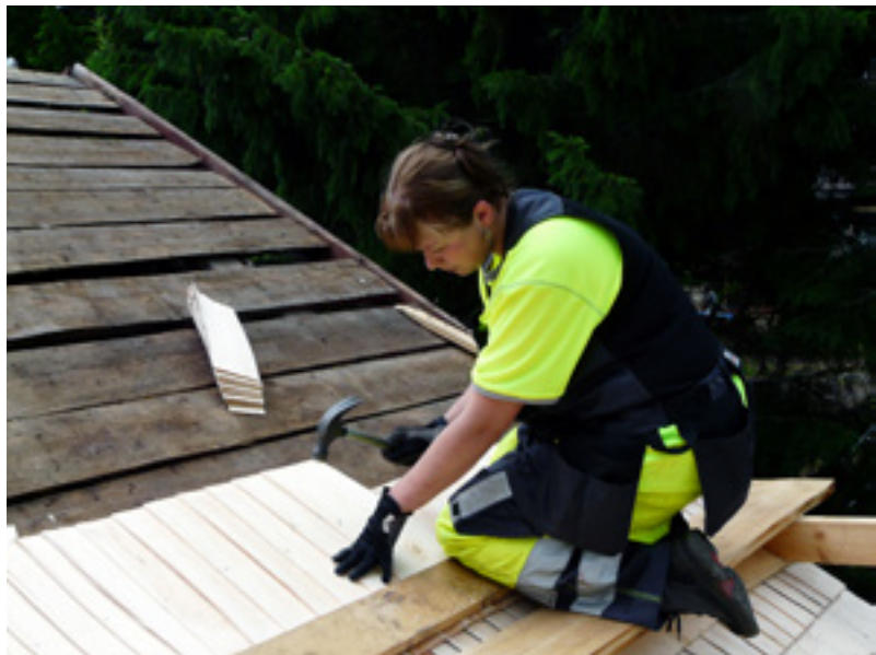
Vaunutallin kunnostamisessa huomioitiin kesäravintola
