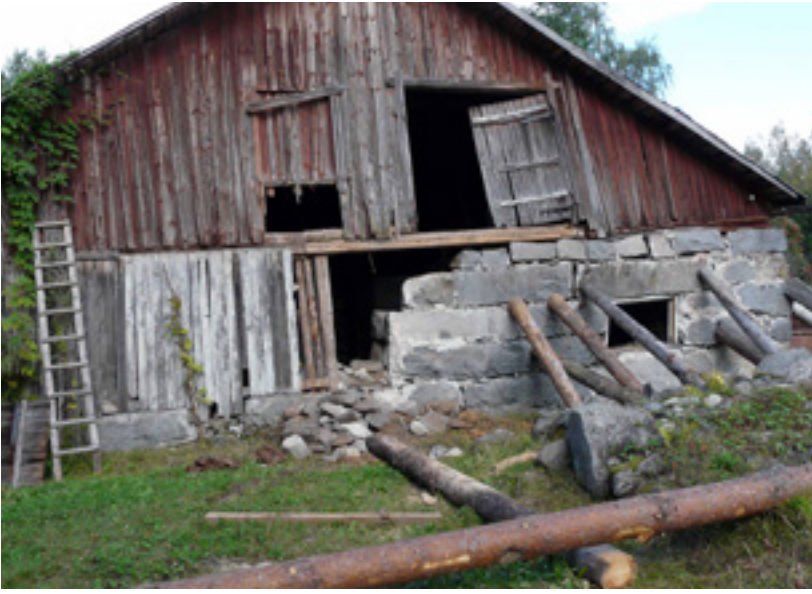
Kivet vaati koneapua takaisin asettelussa, lisäksi kiilausta kiilakivin sekä uudelleen saumauksen
