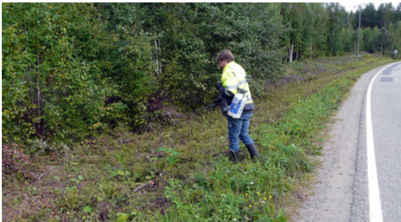
Tiealueella jättiputken torjuntaa Savonlinnassa
