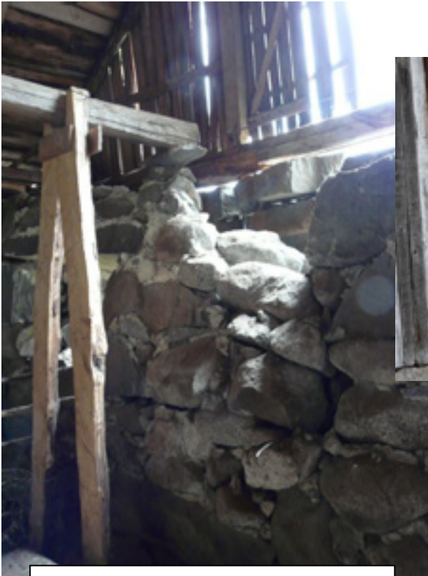
Kaksinkertaisen kiviseinän ulko- ja sisämuurit ennen korjausta.
