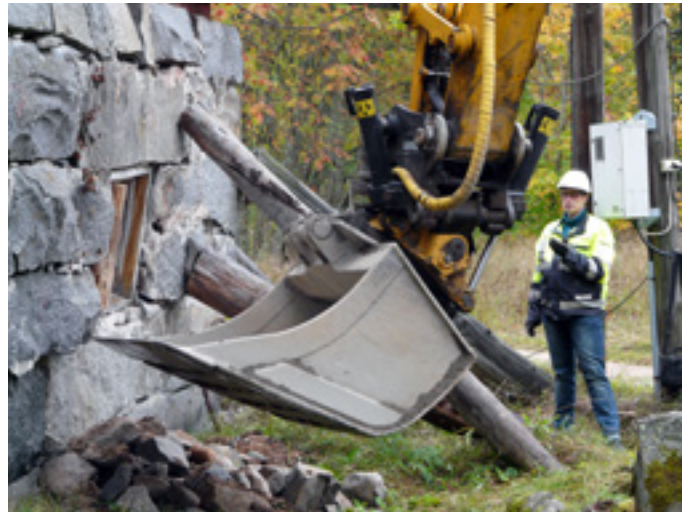
Kivet vaati koneapua takaisin asettelussa, lisäksi kiilausta kiilakivin sekä uudelleen saumauksen
