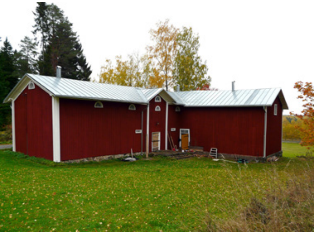
Heinäveden kotiseutumuseon kunnostusvaiheita
