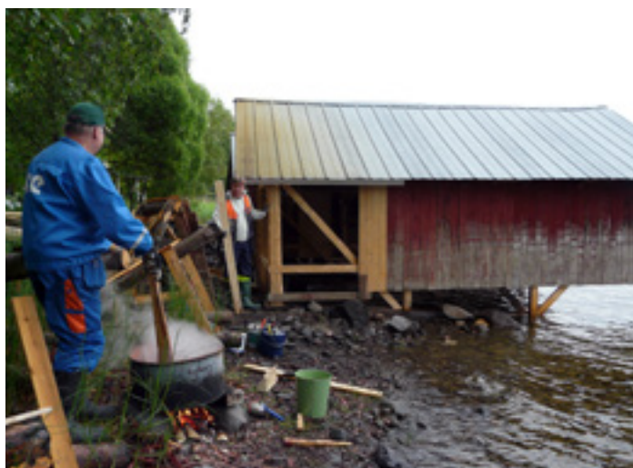
Venekatoksen kunnostusta eri työvaiheissa Anttolassa
