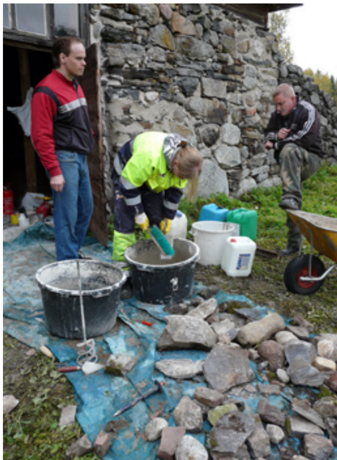
Punkaharjun kotiseutumuseolla työt käynnissä
