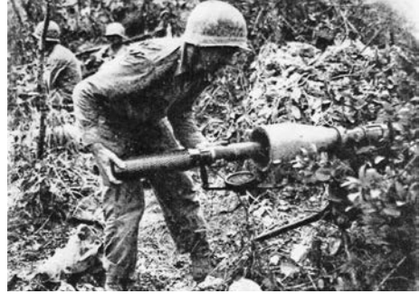
Kuva 6. Rekyylittömän tykin lataaminen ja ammus. Huom. Rei'itetty hylsy, jonka reikien kautta kaasupaine työntyy sivulle panssokammion seinämiä vastaan, poistuen panssokammion läpi säteittäisesti tehtyjen reikien kautta. Tämä järjestelmä aiheuttaa sen, ettei ase hyppelemään sivusuunnassa.
