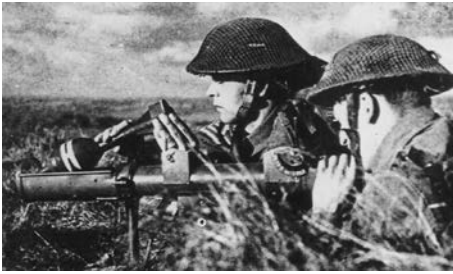
Kuva 3. Engl. PIAT-lähitorjunta-ase. Huom. Lataaminen putken etuosasta.
