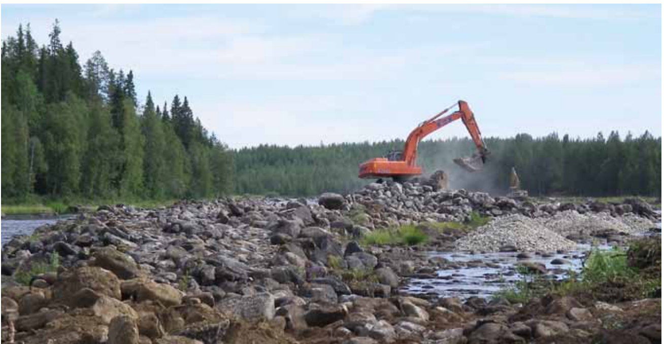
Kuva 21. Kutusoraa odottamassa levitystä kunnosteilla olevaan koskeen.
