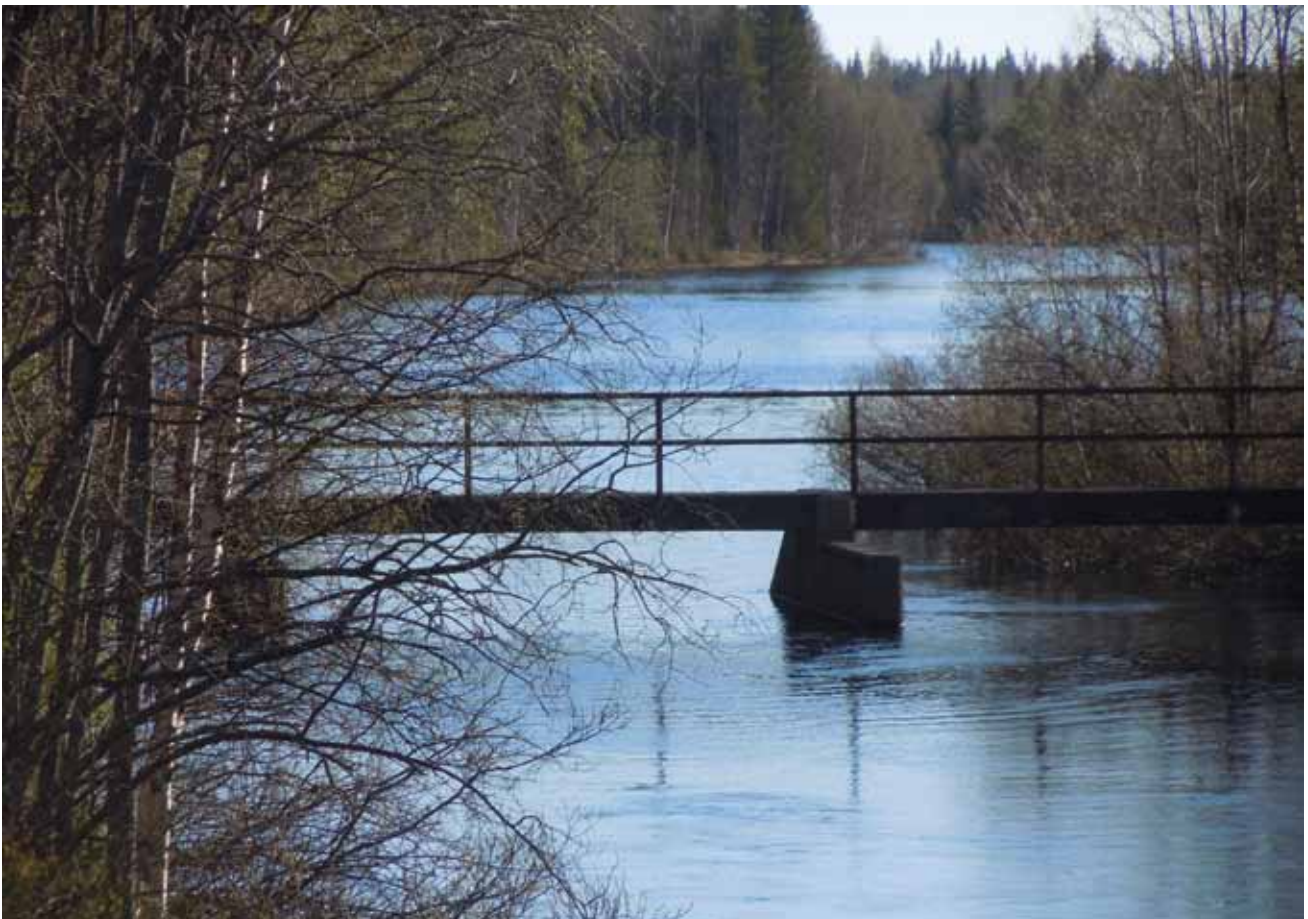
Kuva 10. Kuusamontien vieressä Kalliojärven uittopadon jäljellä olevat betonirakenteet.
