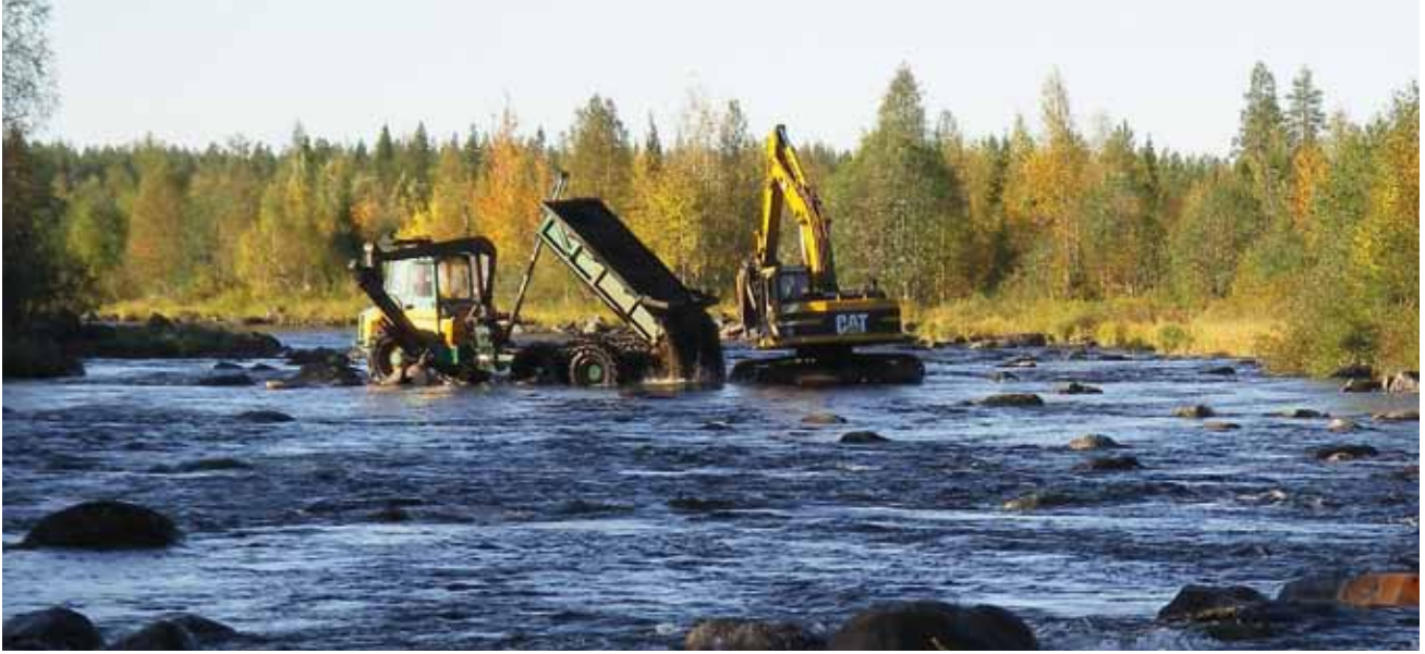
Kuva 4. Koskien kunnostustöihin käytettyjä koneita rakentamassa kutusoraikkoja Kostonjoella.
