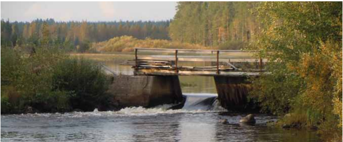
Kuva 6. Hirvaskosken voimalaitoksen säännöstelypato.
