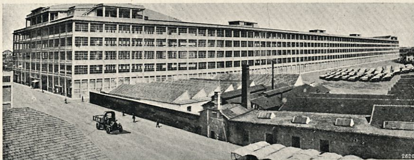
Kuva 1. Uusi tehdasrakennus Lingottossa Torinon luona. 800 metriä pitkä.
