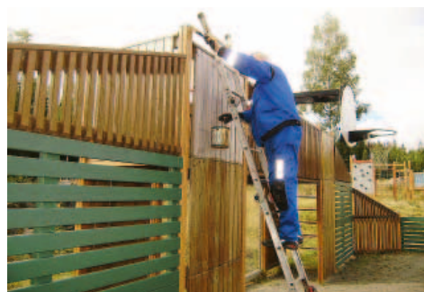
Pelaitaus sai uuden maalipinnan.
