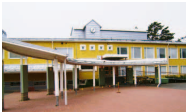
Rannankylän koululla maalattiin rakenteita.
