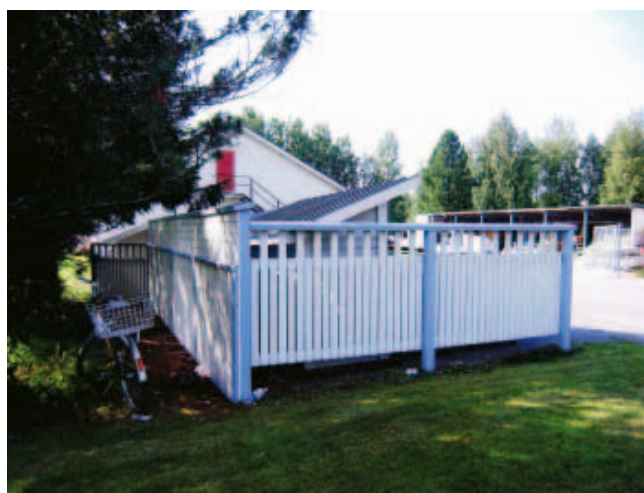
Kunnan varaston aitaus maalattiin ja aidan vierestä poistettiin pensaikkoa.
