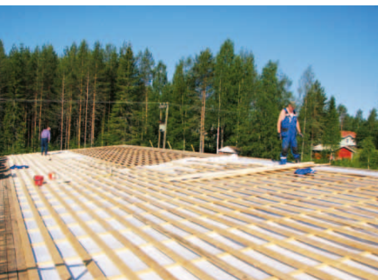
Rautavaaran kunnan varaston katto kunnostettiin uusimalla alusrakenteet ja laittamalla uusi peltikate.
