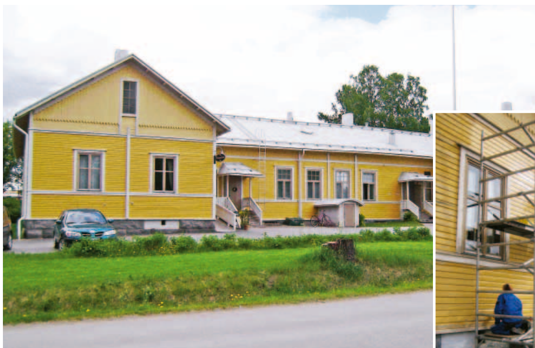
Ulkovuorauksen ja ikkunoiden puitteiden maalaukset toivat ryhtiä puurakennukseen.
