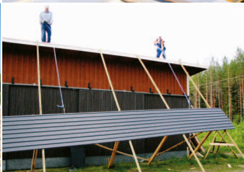
Rautavaaran kunnan varaston katto kunnostettiin uusimalla alusrakenteet ja laittamalla uusi peltikate.
