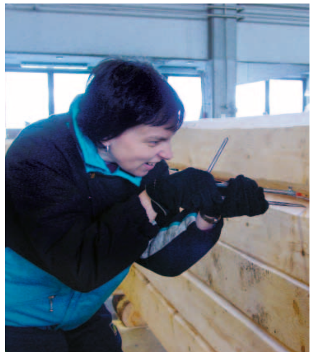
Koulutuksen aikana päästiin kokeilemaan hirsitöitä. Varauksen teko vaatii tarkkuutta.
