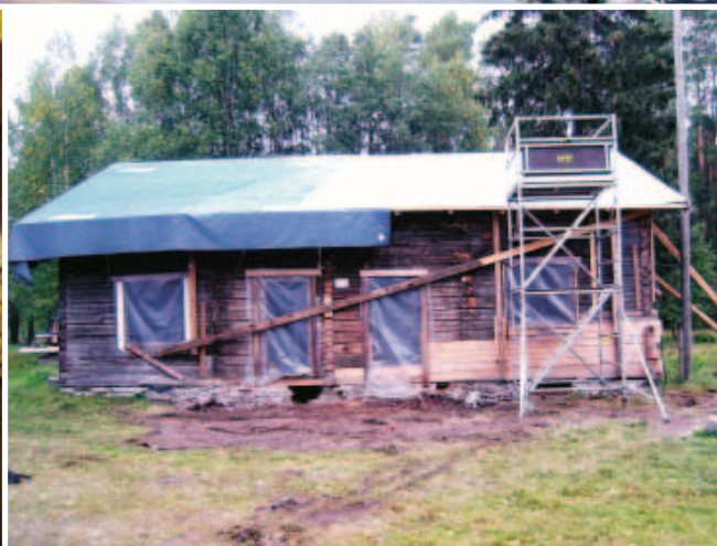
Mäntylän talon kunnostus on tuonut työn myötä monia yllätyksiä. Tuvan päädyssä jouduttiin uusimaan alaosan hirret. Kuistiosa osoittautui korjauskelvottomaksi ja se jouduttiin purkamaan. Ulkokuorauksen kunnostaminen siirtyi seuraavalle vuodelle.
