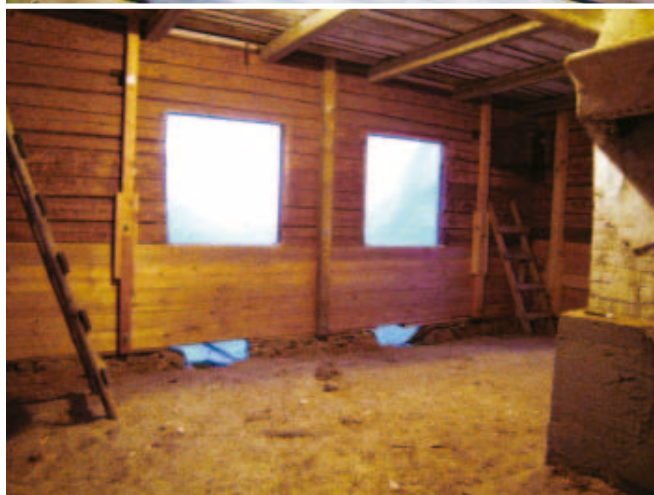
Mäntylän talon kunnostus on tuonut työn myötä monia yllätyksiä. Tuvan päädyssä jouduttiin uusimaan alaosan hirret. Kuistiosa osoittautui korjauskelvottomaksi ja se jouduttiin purkamaan. Ulkokuorauksen kunnostaminen siirtyi seuraavalle vuodelle.
