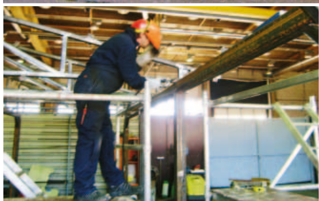
Suurin työkohte oli linja-autokatoksen eli bussiterminaalin teko. Katoksen metalliosat tehtiin varastolla valmiiksi ja pystytettiin paikalleen. Tämän jälkeen katokseen tehtiin katto ja kaiheet. Katoksessa on kaksi erillistä osaa, toinen alakoululaisia ja toinen yläkoululaisia varten.
