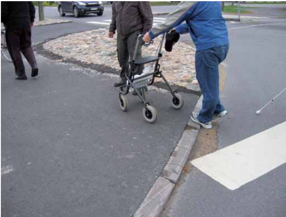
Kuva 28. Reunakivet esitetään madallettavaksi ja/tai korjattavaksi resurssien mukaan taajaman ydinkeskusta-alueella liikkumisesteisten liikkumisen helpottamiseksi.
