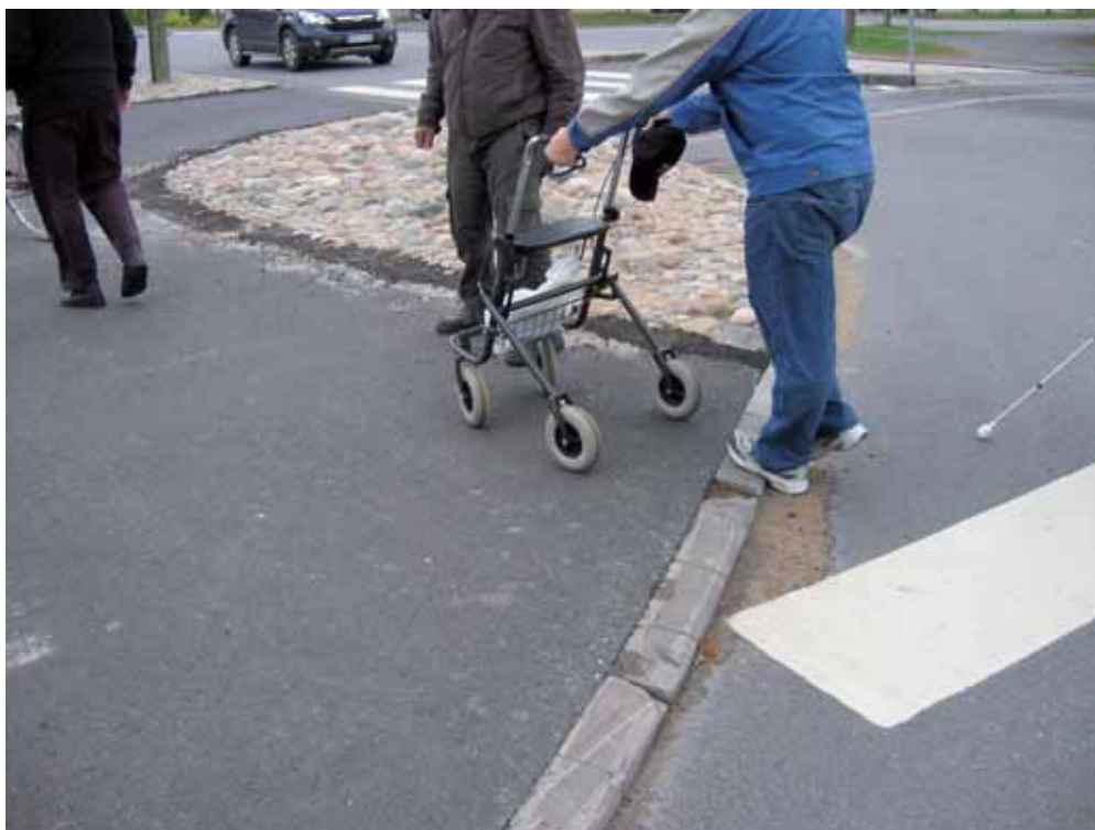
Kuva 33. Reunakivet esitetään madallettavaksi ja/tai korjattavaksi resurssien mukaan taajamien ydinkeskusta-alueilla liikkumisesteisten liikkumisen helpottamiseksi.
