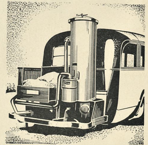
BAHCO-puhdistin linjavaunuun asennettuna.
