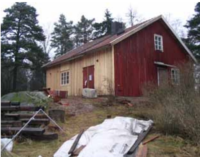
Leivintuvan ulkolaudoitusta hirsikorjausten jälkeen punamultaa odottaessa.
