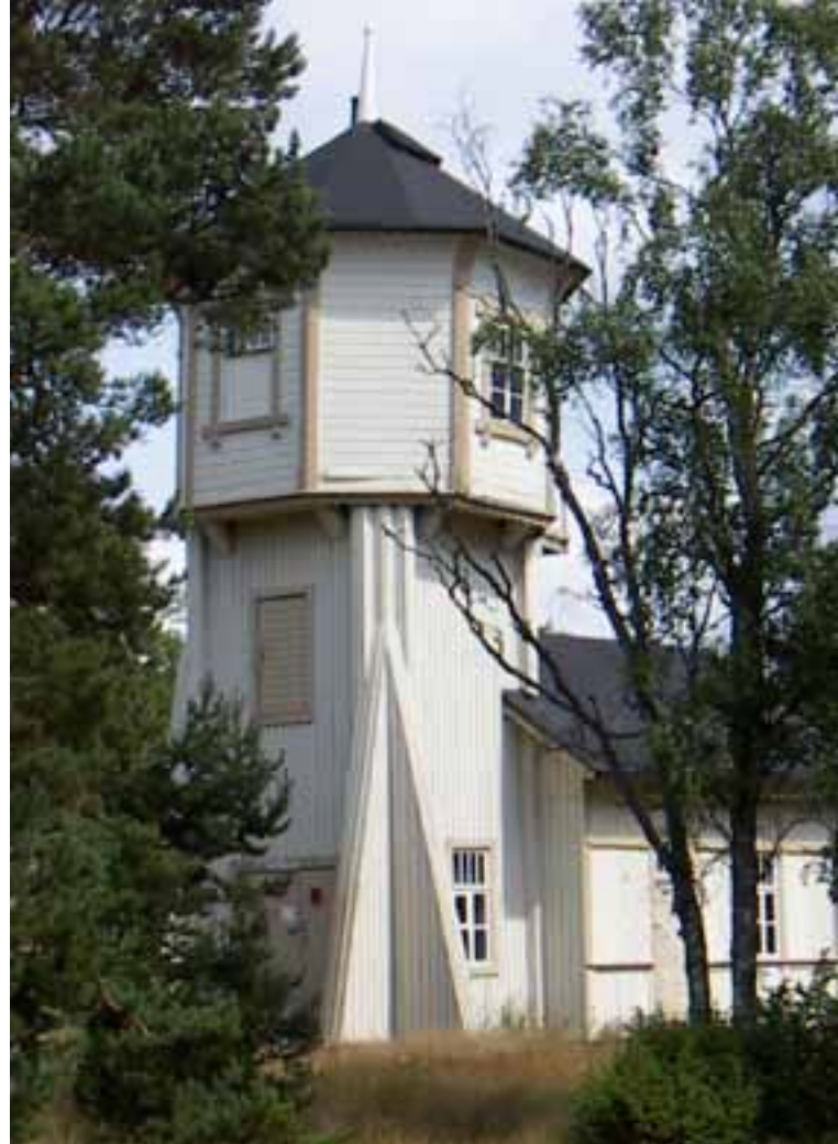
Vuonna 1916 valmistunut vesitorni, Katanpää. Kuva: Varsinais-Suomen liitto, Heikki Saarento
