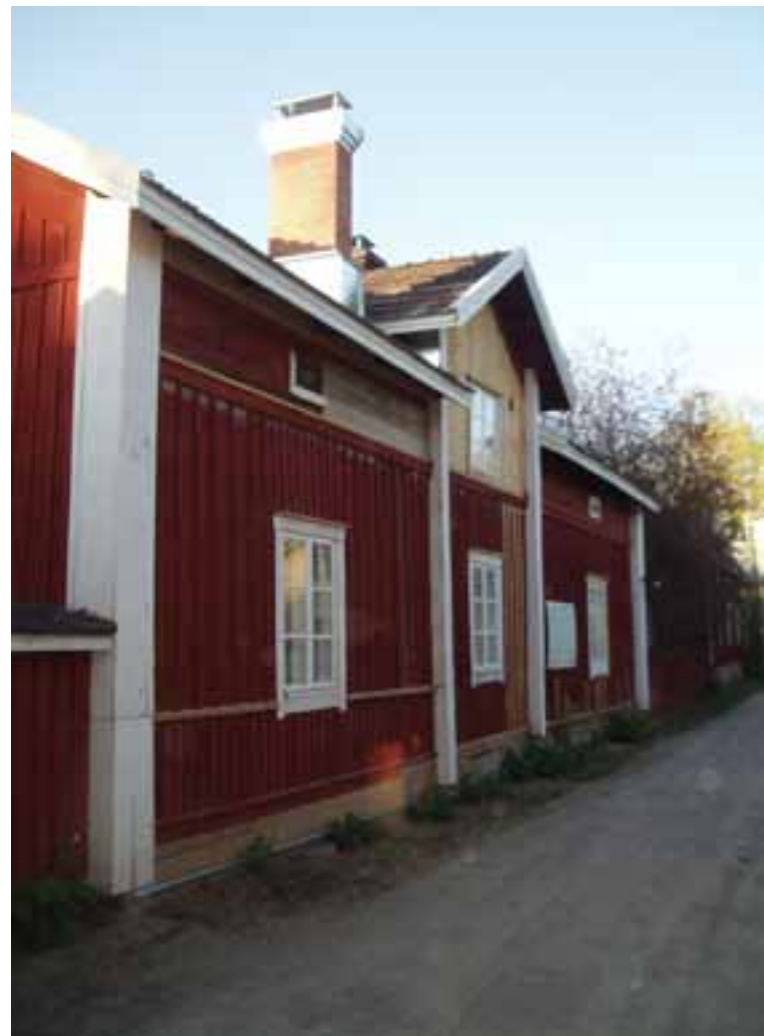
Björkfeldtin talon julkisivu korjattiin paikkaamalla. Kuva: Varsinais-Suomen ELY-keskus, Anna-Leena Seppälä
