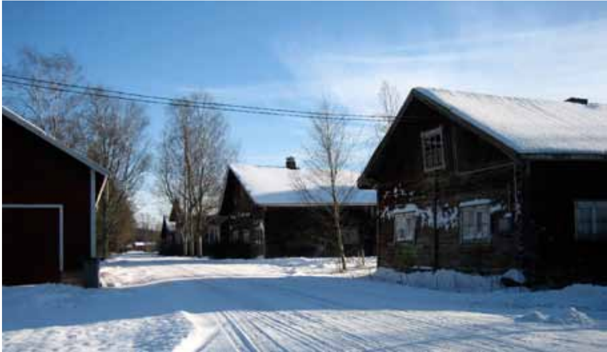
Harvinaisen hyvin säilynyt rakennetun ympäristön kokonaisuus valtakunnallisesti merkittävän Huovintien varrella. Koski Tl:n Isosorvaston kylään kuuluvaan Urmaankulmaan siirrettiin 1700-luvun lopulla kantatalot Ylihyhkö, Yliurmas, Aliurmas ja Mäkilä. Kuva: Turun museokeskus, Paula Saarento 2008
