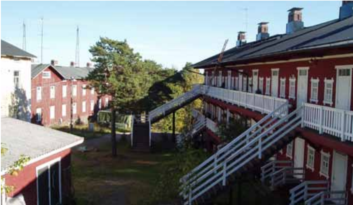
Luhtitalot ovat ruukkiyhdykskunnalle tyypillisiä vuokrakasarmeja Taalintehtaan valtakunnallisesti merkittävässä rakennetussa kulttuuriympäristössä. Kuva: Varsinais-Suomen ELY-keskus, Anna-Leena Seppälä 2005
