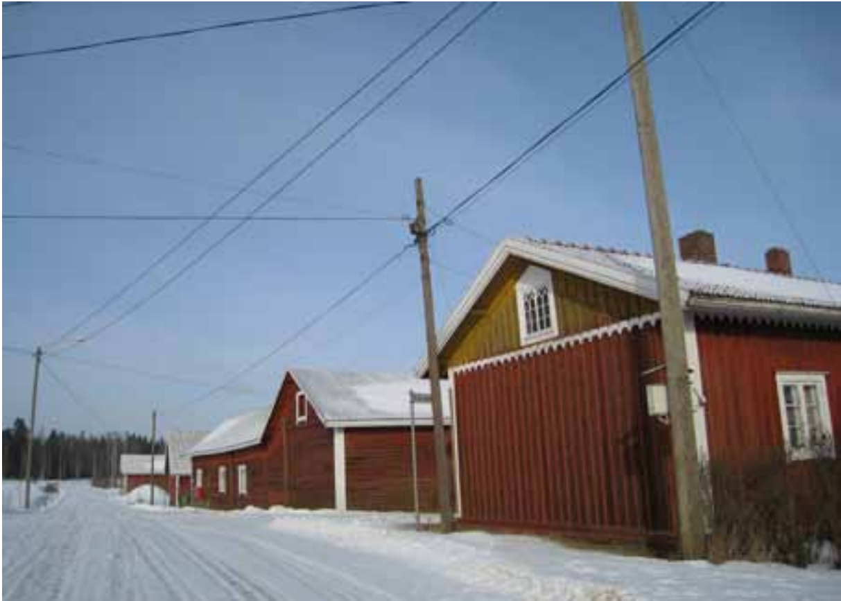
Ulkorakennukset ovat merkittävä osa kokonaisuutta. Loimaan Metsämaan ryhmäkylän kantatalojen ulkorakennukset muodostavat selkeitä kujanteita. Kuvassa Ala-Tuomolan ja Ala-Koppalan ulkorakennuksia raitin varressa. Kuva: Varsinais-Suomen liitto, Kirsti Virkki 2009
