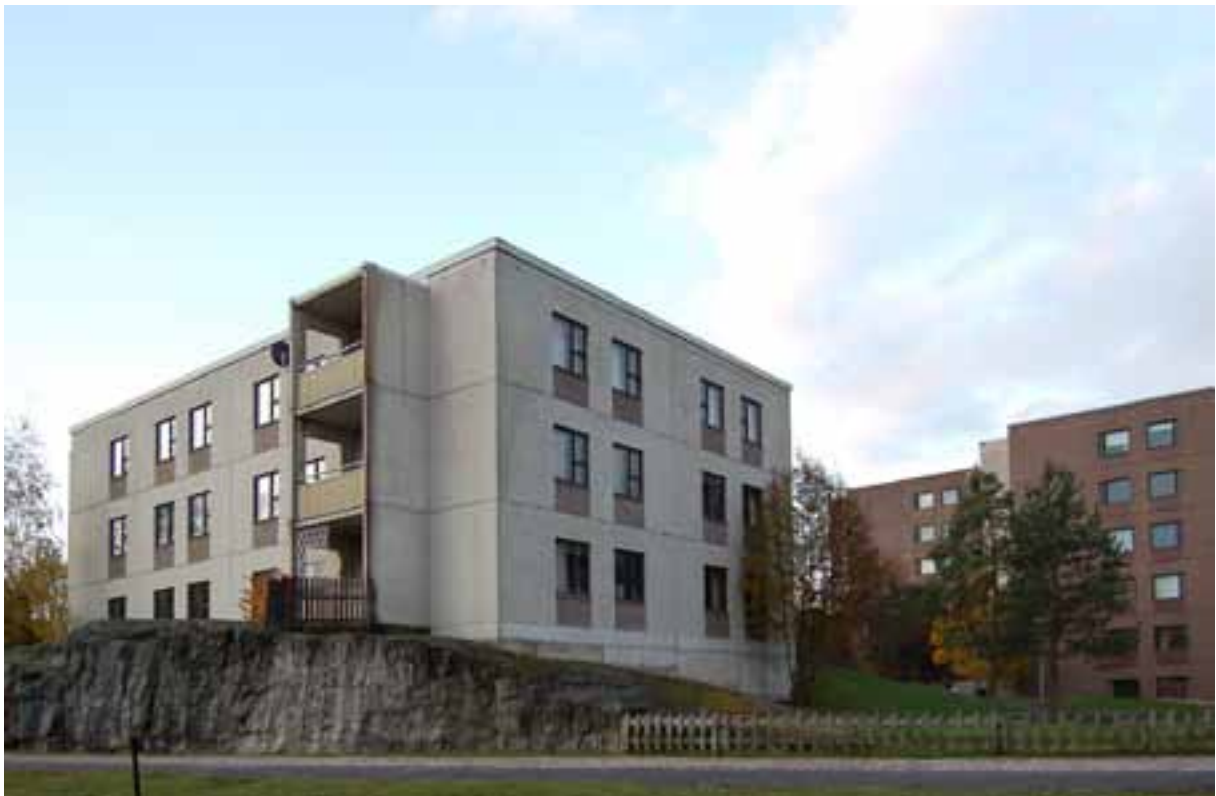
Karvataskunkadun kerrostaloissa Varissuolla näkyy vielä alkuperäinen pesubetonijulkisivu. Elementtijaossa, julkisivun värikentissä ja ikkunajaossa näkyy ajalleen poikkeuksellisen kunnianhimoista suunnittelua. Niin sanottu sandwich-elementtitekniikka ei ole kestänyt niin hyvin kuin suunnitteluaikana uskottiin. Lähiössä on yleisesti käynnissä julkisivujen uudelleen verhoilu ja lisälämmöneristäminen. Kuva: Turun kaupunki, Samuli Saarinen 2009
