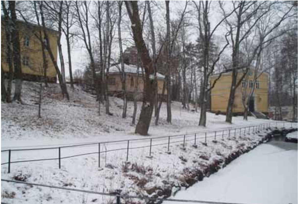
Björkbodan kartanon alueella on EU-varoin kunnostettu sekä vesirakenteita että rakennuksia. Kuva: Varsinais-Suomen ELY-keskus, Anna-Leena Seppälä 2006
