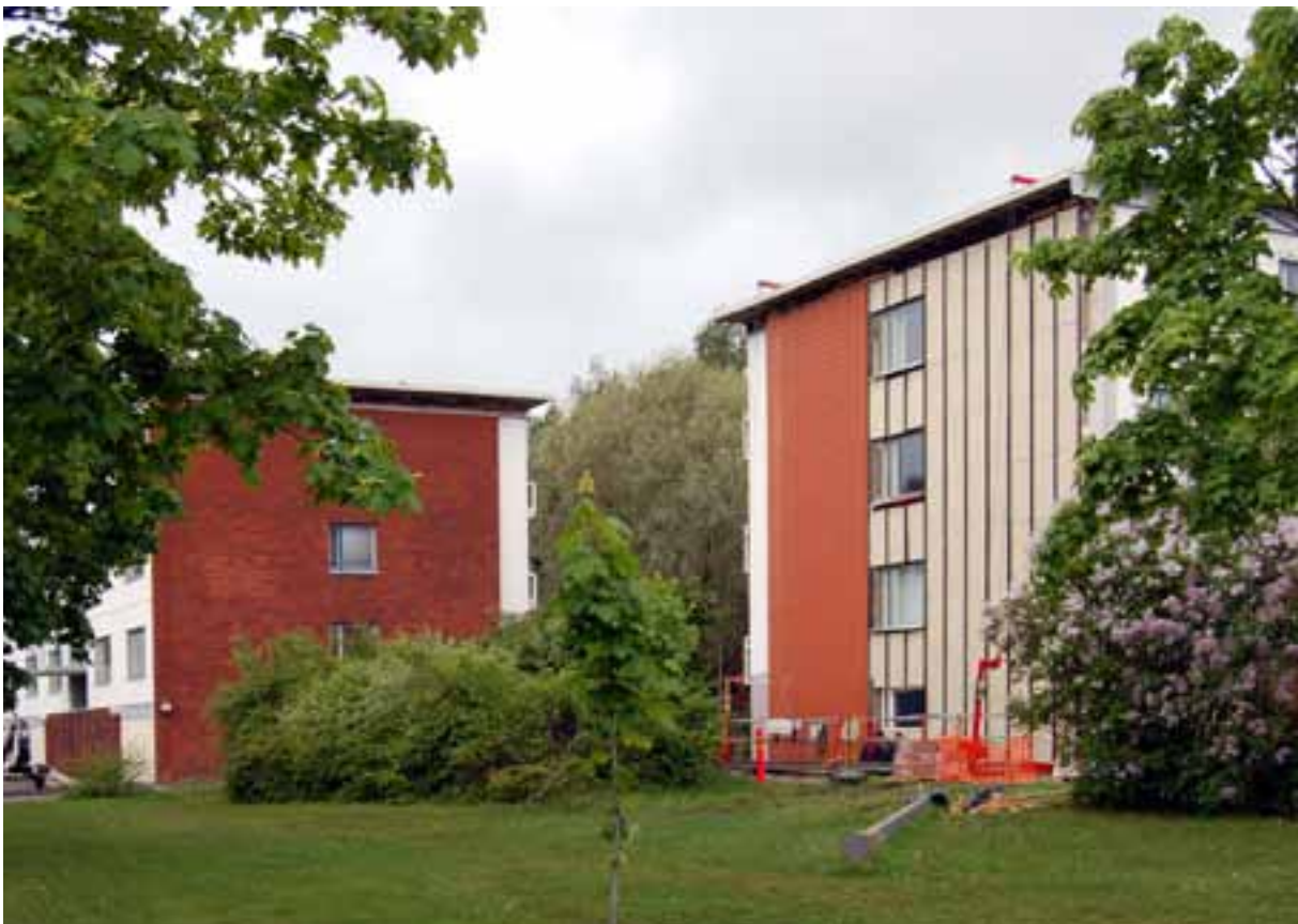
Lähiötalojen julkisivujen korjausta. Kuva: Turun kaupunki, Samuli Saarinen 2009
