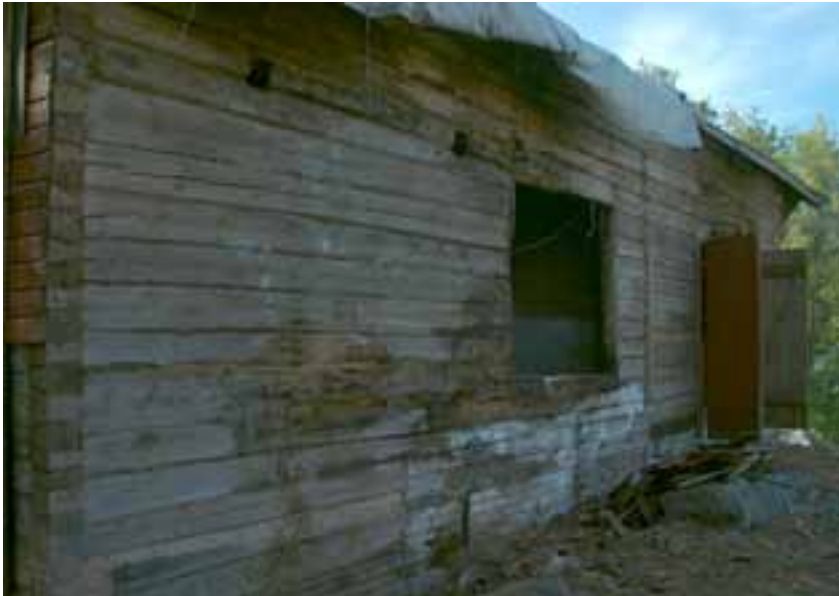
Kemiön leivintuvan hirsirunkoa korjaustyön alkaessa.
