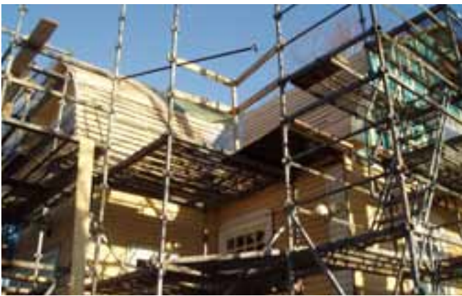
Katon korjausta avustusvaroin Laitilassa. Kuva: Varsinais-Suomen ELY-keskus, Anna-Leena Seppälä, 2009
