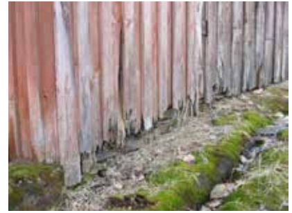
Liiterin julkisivun laudoituksen vaurioita.
