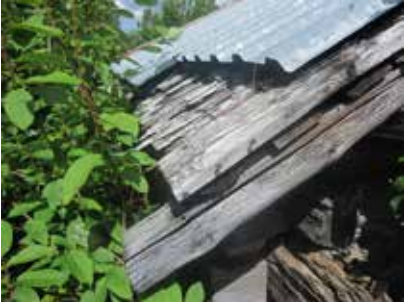
Liian lyhyet kattopellit.
