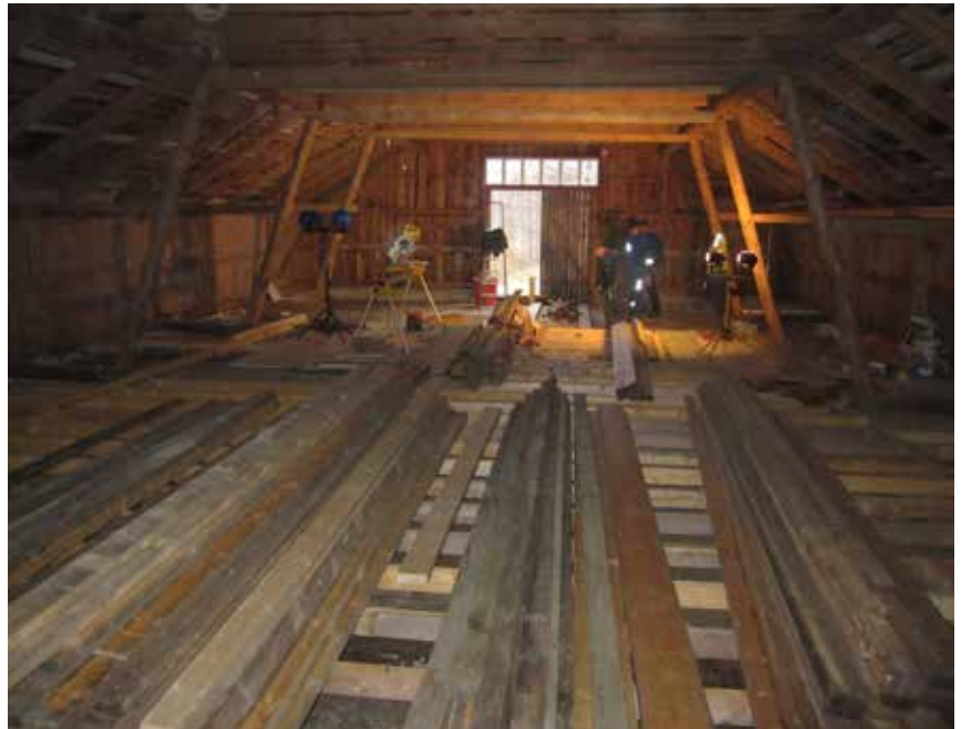
Navetan ylisten lattiarakenteita uusitaan.
