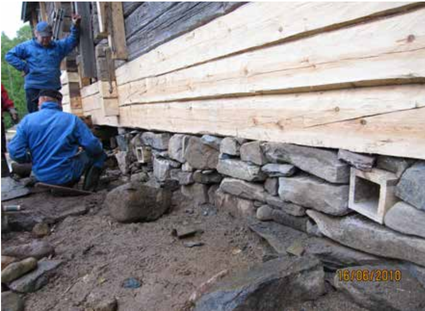
Uusittu sokkeli ja kengitetty hirsiseinä
