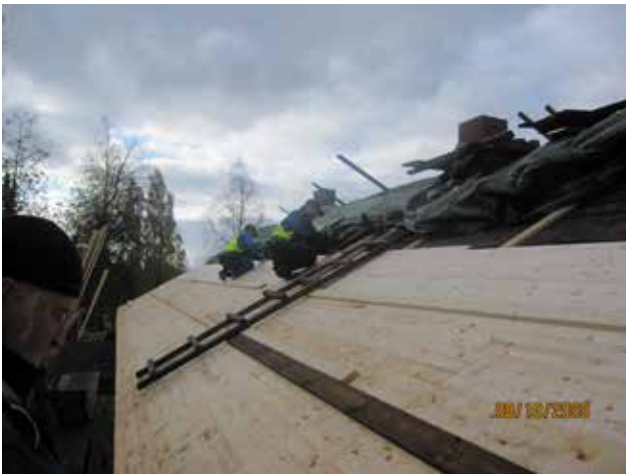
Savupiippujen yläpääät uusittu.
