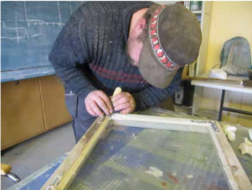
Petri Hirvonen, näyttökokeeseen liittyvä ikkunan kittaus.
