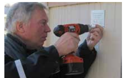
Projektipäällikkö kiinnittämässä muistolaattaa Taiteidentalon seinään Kiihtelys-vaarassa
