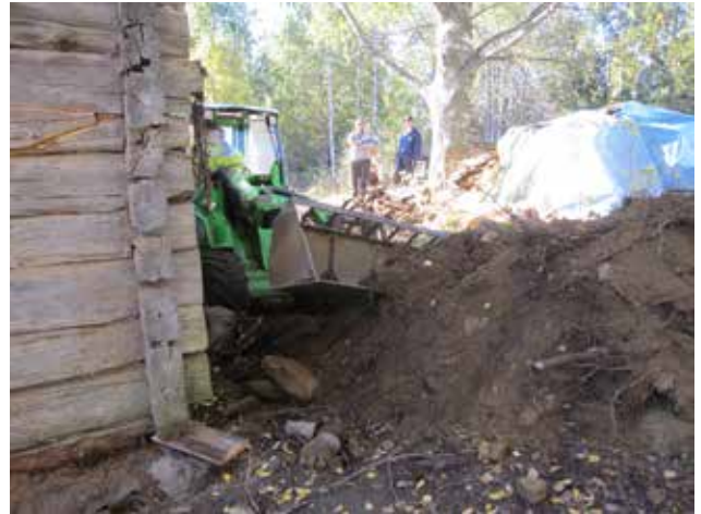
Maanpintaa alennetaan seinän vierellä.
