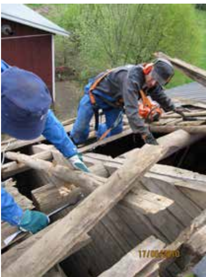
Vesikattorakenteiden korjausta.
