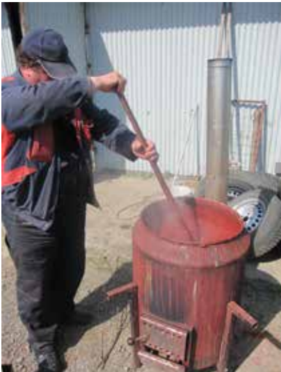
Punamultaa keitettiin tälläkin työmaalla.
