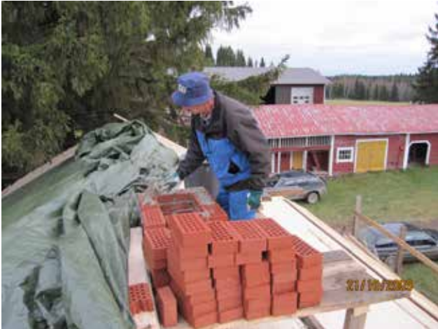
Savupiippujen yläpääät uusittu.
