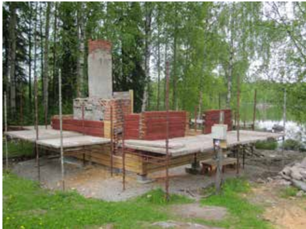
Kehikon kasaus uusituille perustuksille on alkanut.
