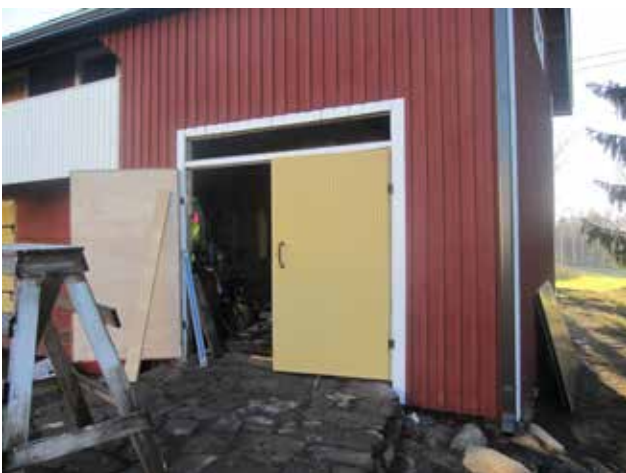
Autotallin ovi on korjattu ja ajoluiska kivetty.
