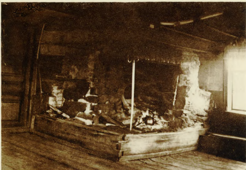
Matti Lampuodin tuvan takkauuni. Uuni takanperässä, suu tuvan peräseinää kohden. Siv. 30.
