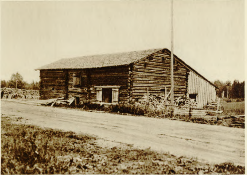
Kellokosken vanha riihirakennus. Päissä riihet, keskellä luuva, jonka alla on ruumenhuone, takana olkilato. Siv. 36.
