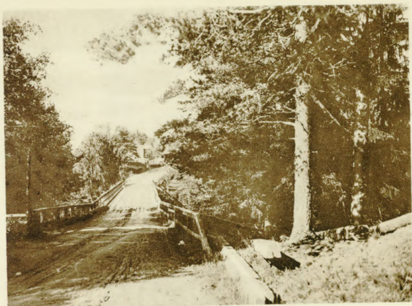
Tunkkarin silta. Siv. 65.
