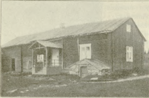
Torikan piharakennus. Ylitornion Nuotioranta.
