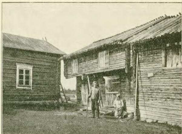
Kittilän talli ja puotirakennus.
