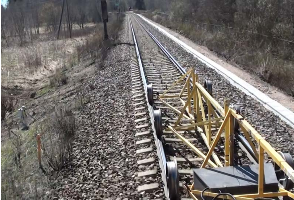
Kuva 20. Stiffmaster-mittauslaitteisto kohteella km 233+900.
