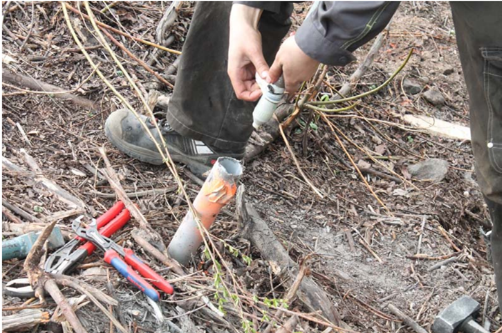
Kuva 17. Huokosvedenpaineanturin asennus kohteessa km 238+280.
