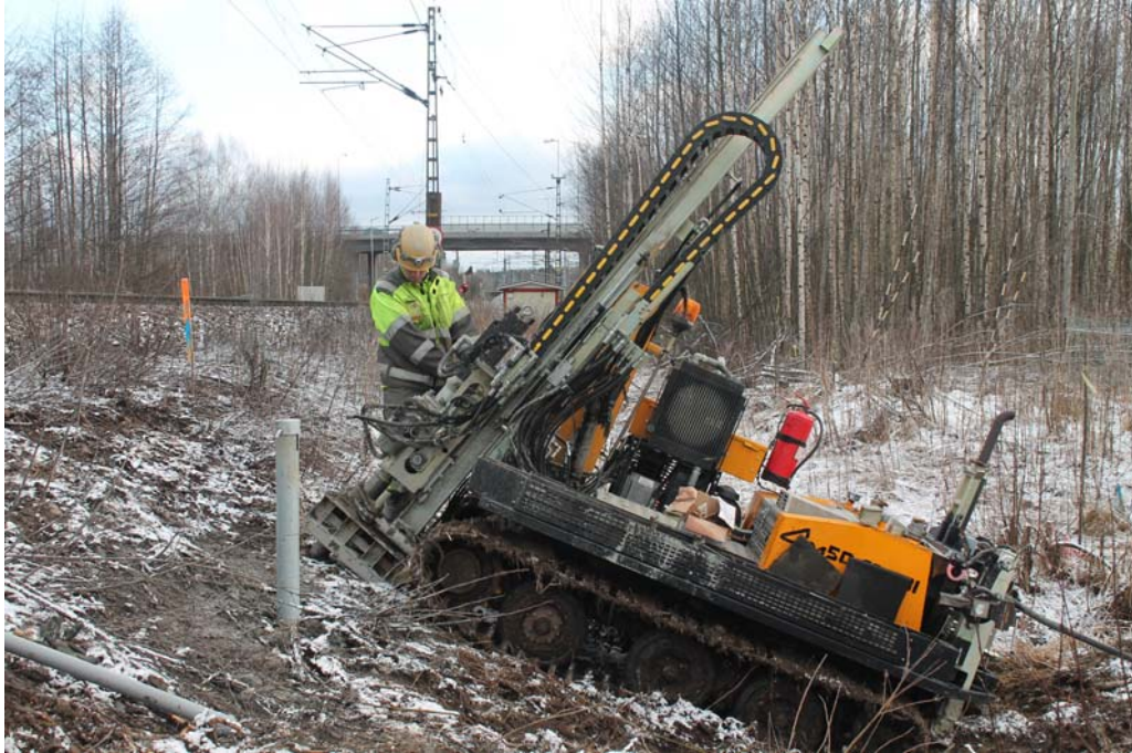
Kuva 13. Huokosvedenpaineantureiden suojaputkien asennus VR:n kairavaunulla kohteessa km 233+900.
