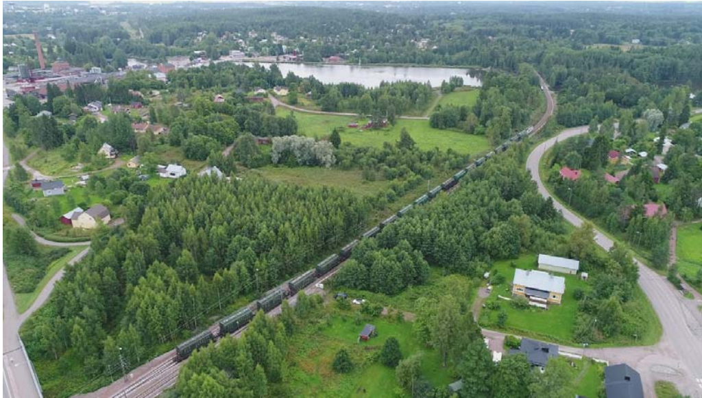
Kuva 23. Pysäytetty 250 kN:n akselipainoisista vaunuista koottu testijuna kohteessa km 233+900.
