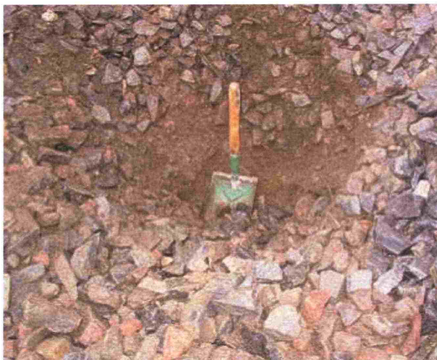
Kuva 4.4. Sepeliä syvällä alusrakenteessa Karviainen–Maaria-välin näytteenotto paikalla.
