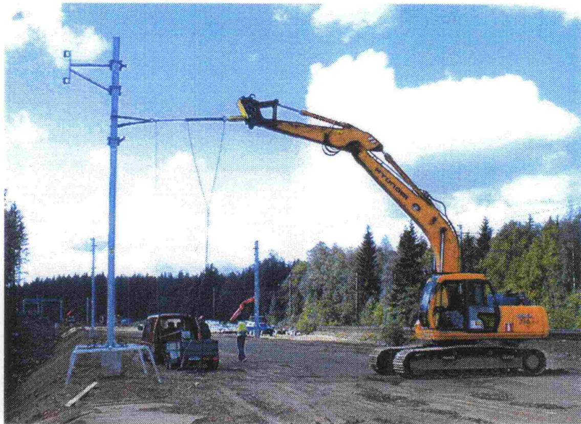
Kuva 2.7. P-pylvään perustuksen koekuormitus kohtisuoraan rataan päin rataosuudella Sääksjärvi-Perkkiö.
