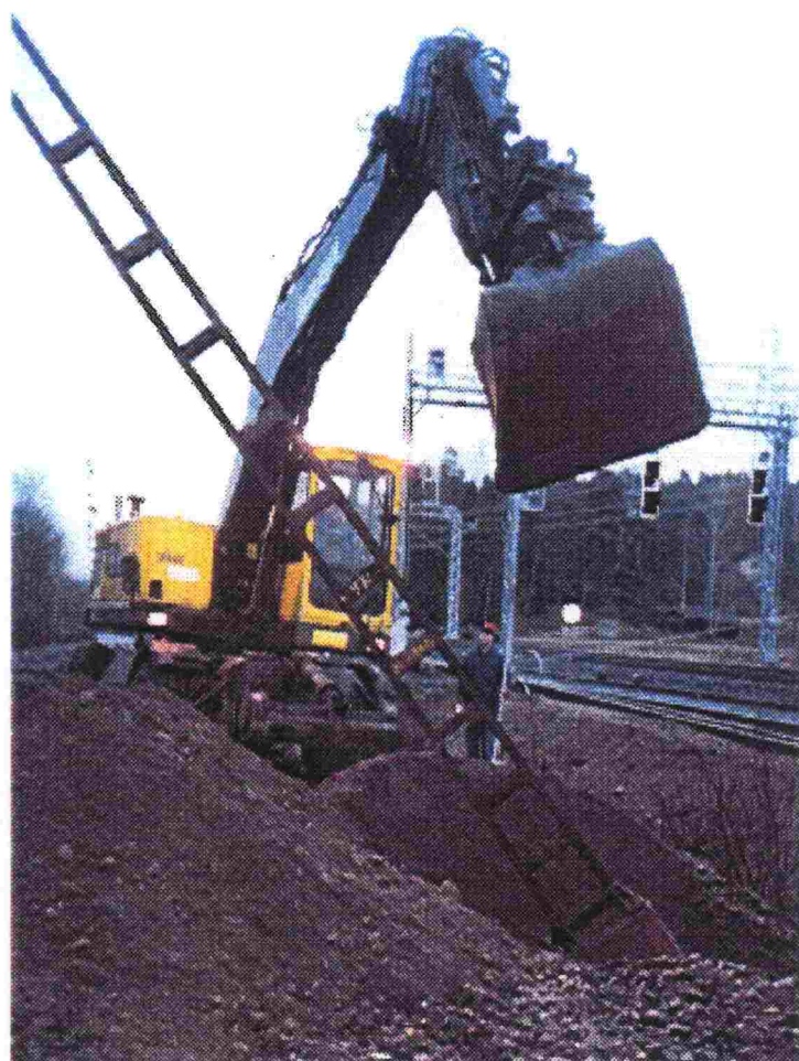
Kuva 2.9. Rataosuudella Säöksjärvi–Perkkiö esiin kaivettu anturaton perustus.
