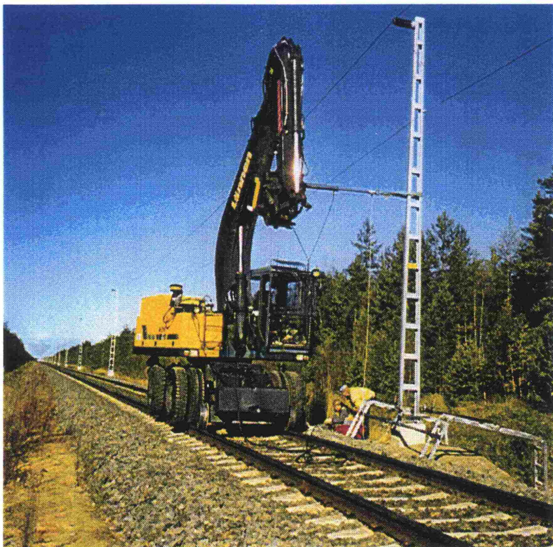
Kuva 2.6. I-pylvään perustuksen koekuormitus kohtisuoraan rataa päin rataosuudella Tuomioja–Raahe.
