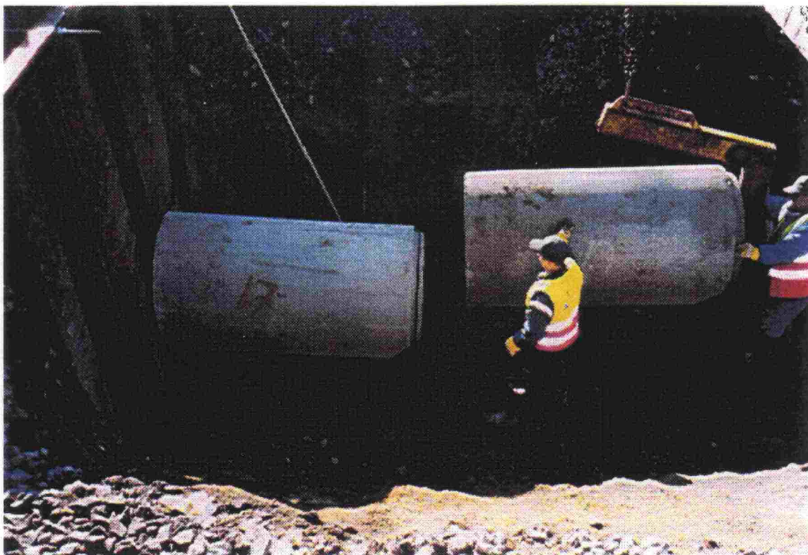
Kuva 2.4:5 Rumpuputkien asentaminen ponttiseinästä alkaen.
