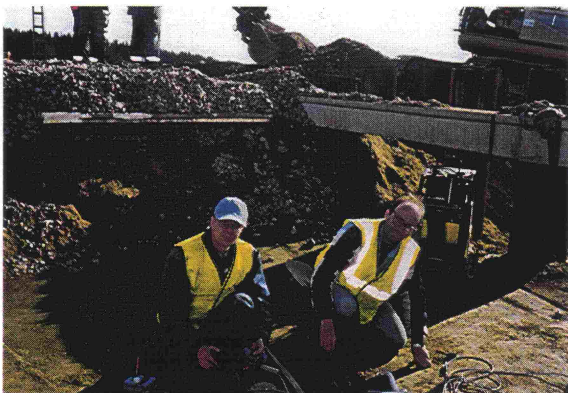
Kuva 2.4:7 Pystyyn asennettavien venymäantureiden asentamista rummun päällä olevassa täytössä (Kv -1,7 m).
