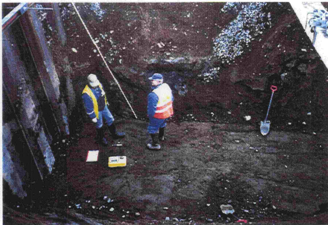
Kuva 2.4:4 Tiiviyden mittaamista sora-arinan päältä.
