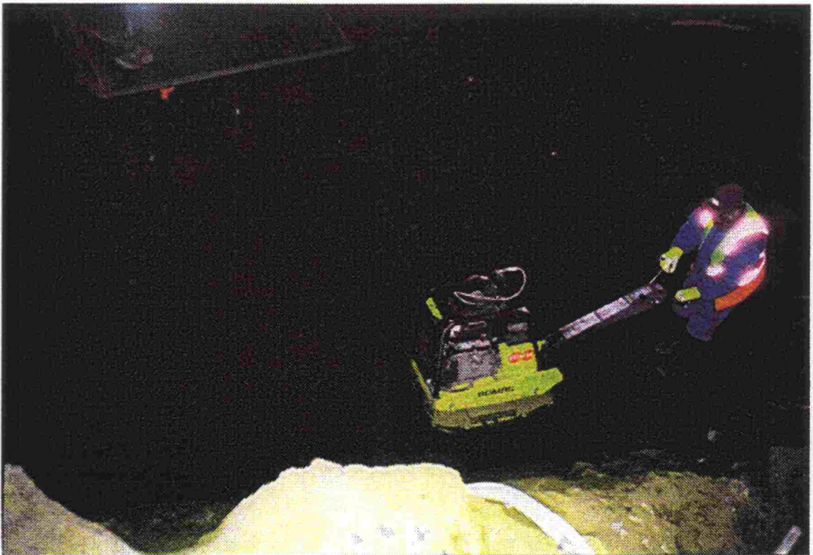
Kuva 2.4:3 Sora-arinan tiivistämistä Bomag BPR 50/52 D-2 -tyyppisellä tärylevyllä.
