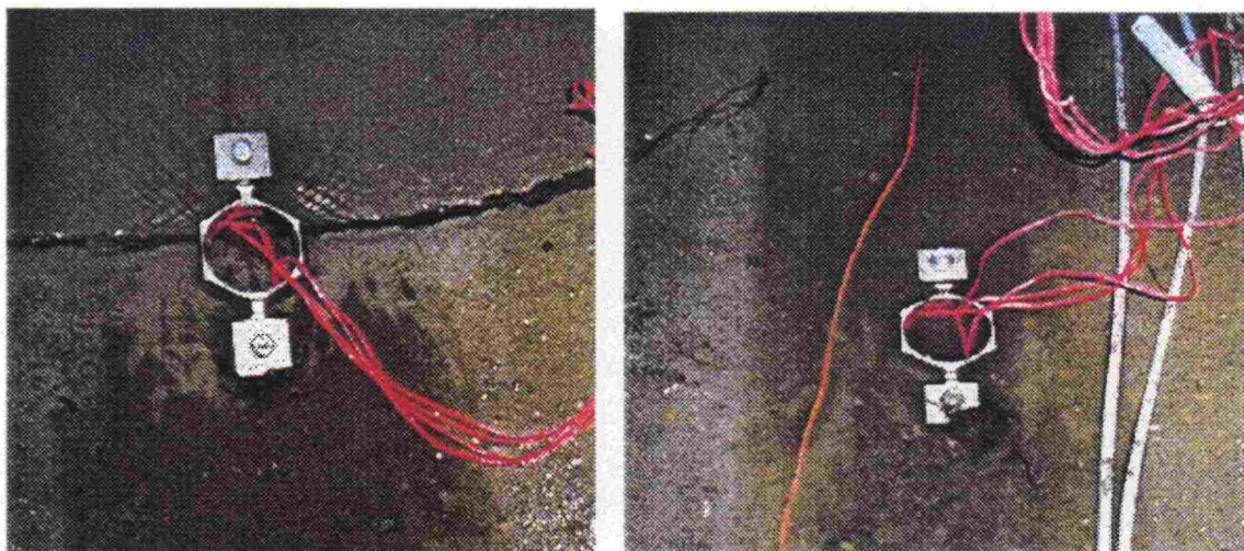
Kuva 2.4:12 Rummun pohjalle pituussuuntaan asennettu venymäkehikko (a) sauman ja (b) rumpuelementin keskikohdalla.
