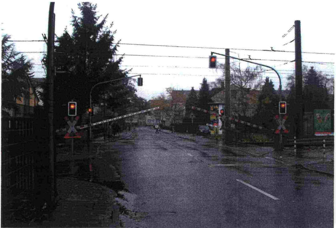
Kuva 23. Puolipuomilaitos Kölnissä Saksassa.
