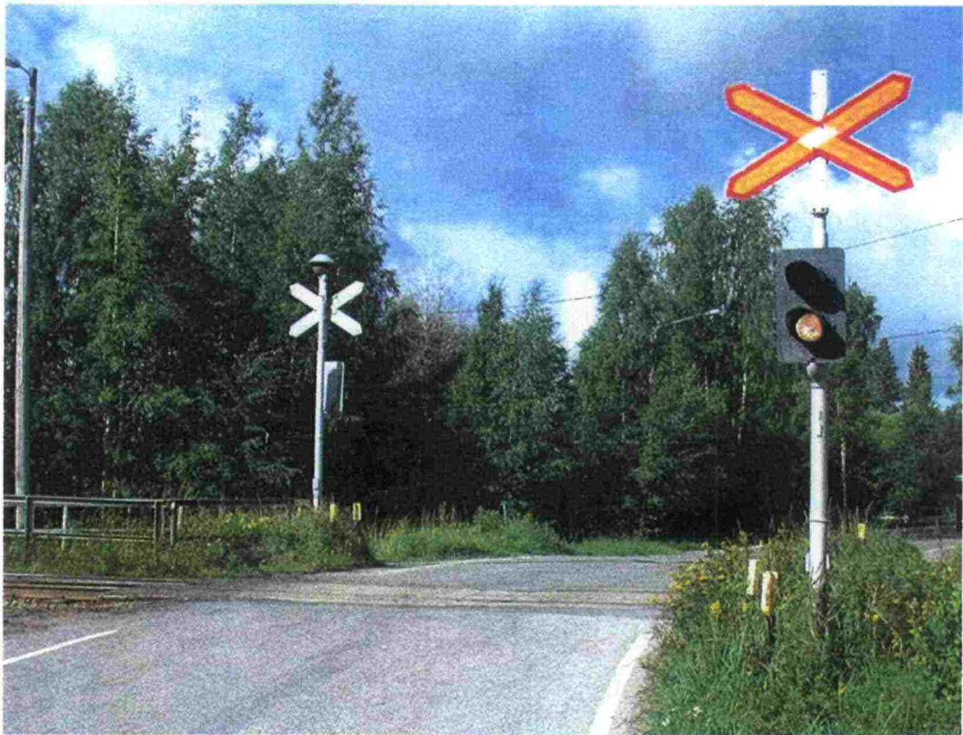
Kuva 2. Valo- ja äänivaroituslaitos Haukiputaalla.
