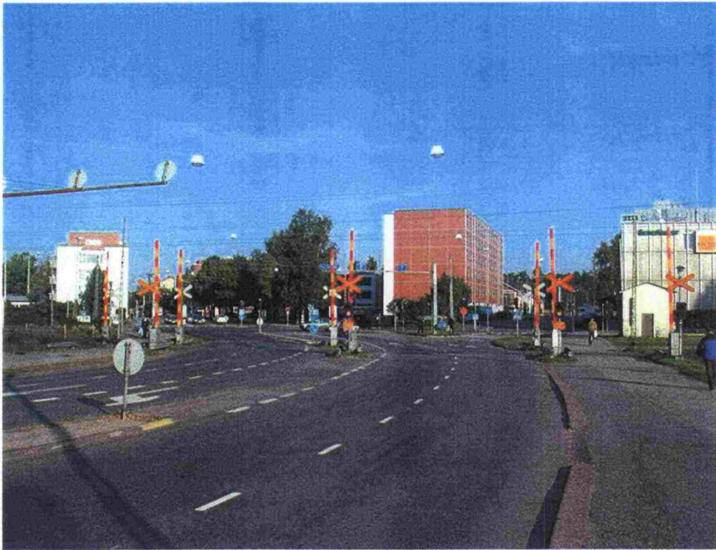
Kuva 7. Valtakadun puomilaitos Raumalla.
