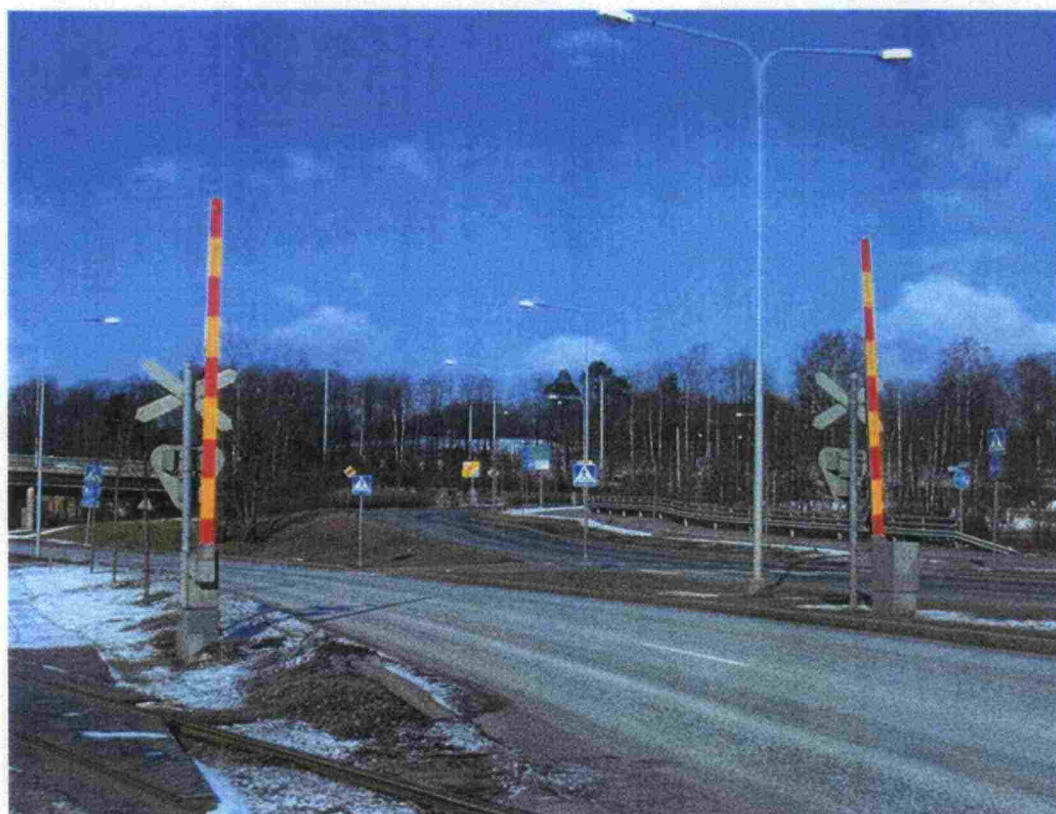
Kuva 1. Molemmat kaistat sulkeva puomilaitos Hermannin rantatiellä Helsingissä.
