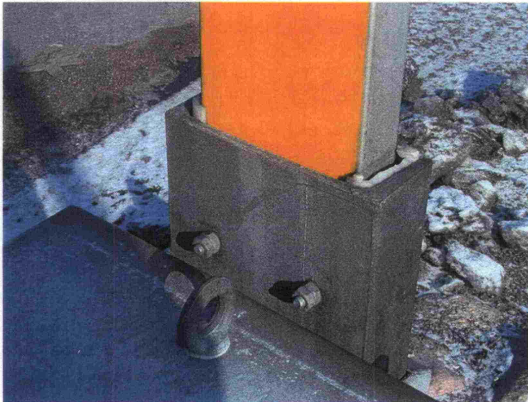
Kuva 3. Murtopultit puomin kiinnityksessä.
