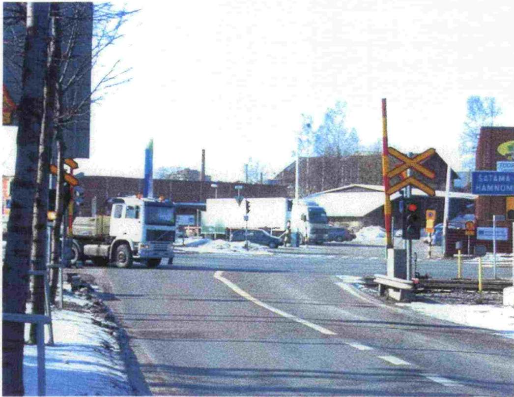
Kuva 8. Tasoristeys, jossa valoyksikkönä normaali liikennevaloyksikkö.
