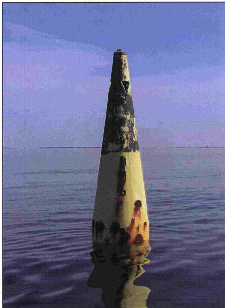
Kuva 13, Huonokuntoinen pohjoisjääpoiju Saaristomerellä
