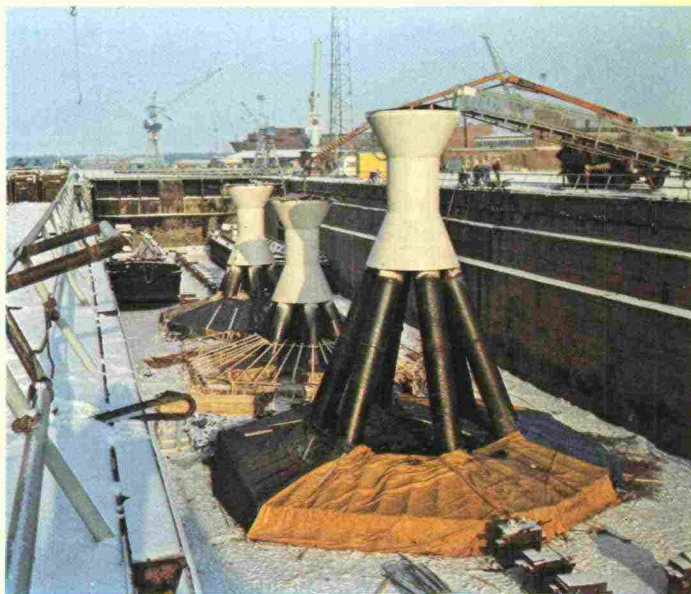
Rauman väylän reunamerkkien perustuksia telakka-altaassa
