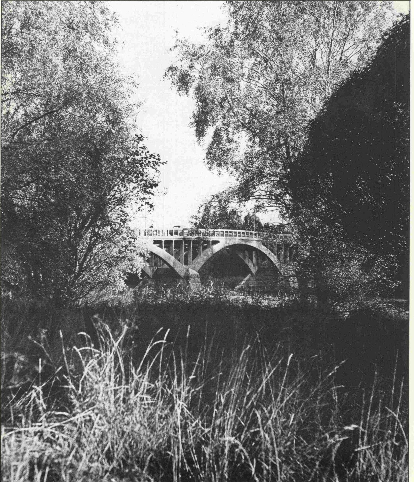
Tulkkilan vuonna 1918 valmistunut betonisilta Kokemäellä on eräs tiemuseokohde
