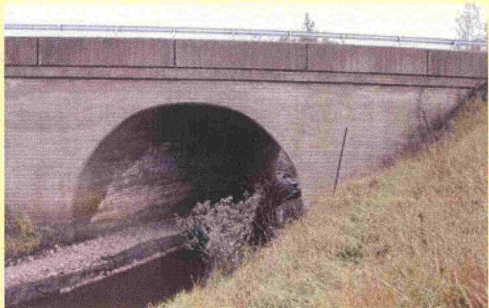
Kuva 48. Karjajoen silta kuivapolun kunnostuksen jälkeen. Valokuva: Niina Jääskeläinen.
