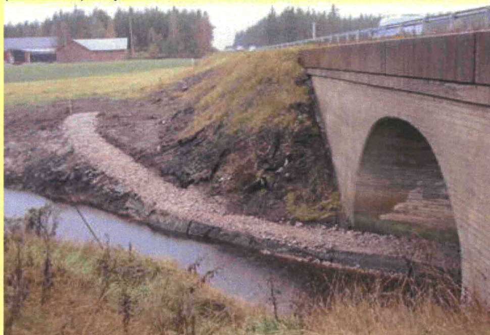
Kuva 45. Karajoen sillan kuivapolku. Valokuva: Niina Jääskeläinen.
