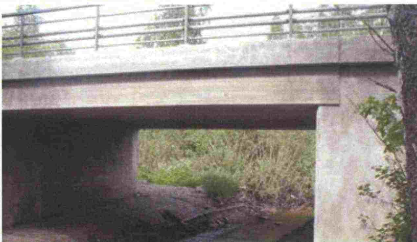
Kuva 38. Betonilaattasilta ja kuivapolut. Valokuva: Milla Niemi.
